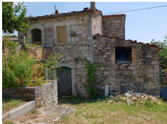
Particolare facciata di ingresso del fabbricato di cui al lotto 2
