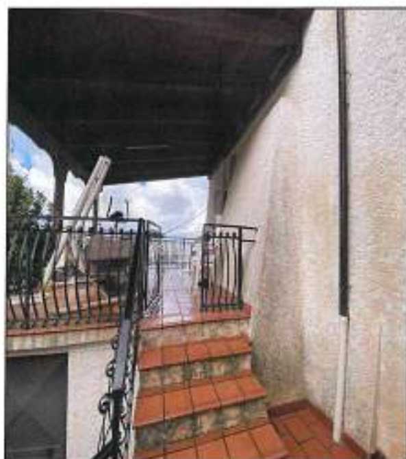
Foto n° 10 – Vista scala ingresso portico, sono visibili le pavimentazioni in cotto e ringhiera in ferro.
