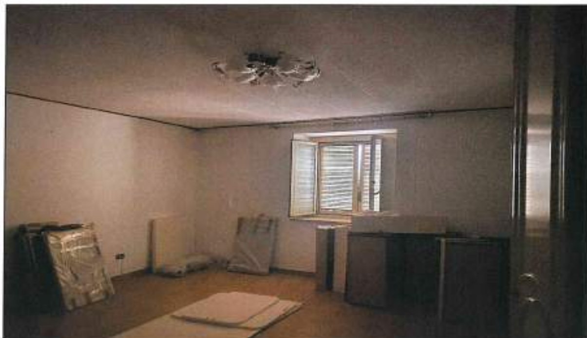
Foto n° 26 – Vista interna locale sala presente nella u.i. sub 9, sono visibili e presenti ottime rifiniture, in quanto l'u.i. ha avuto lavori di ristrutturazione.
