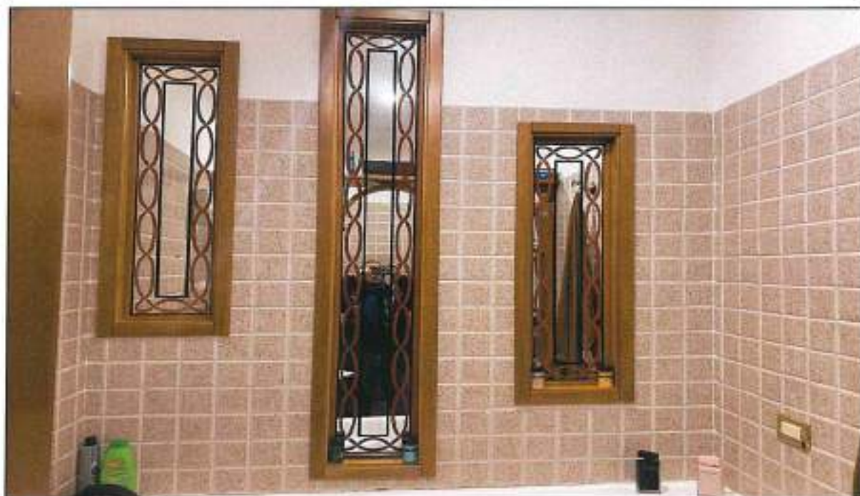
Foto n° 14 – Vista interna locale wc presente nella u.l. sub 6, sono visibili e presenti ottime rifiniture, in quanto l'u.l. ha avuto lavori di ristrutturazione.
