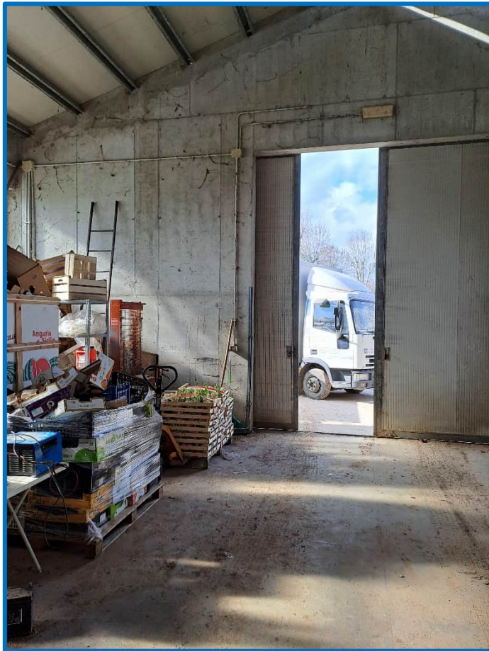
n° 7 Interno capannone
