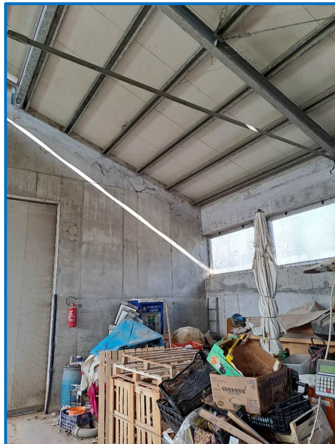
n° 6 - Interno capannone
