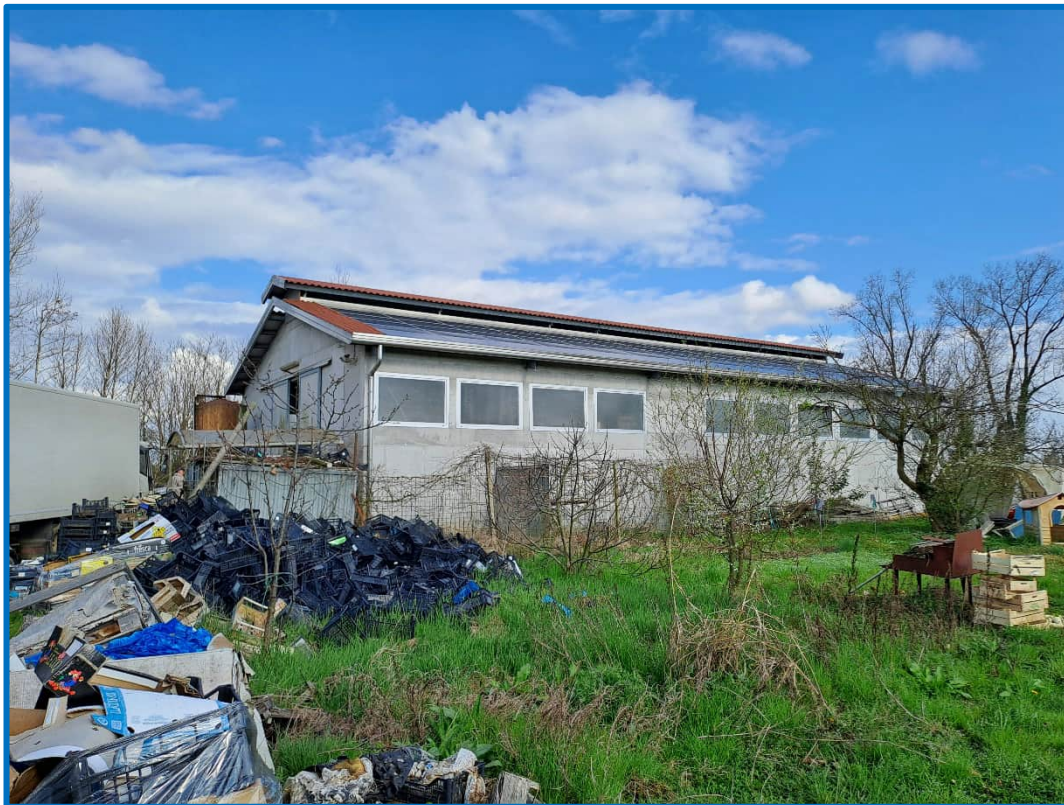
n° 1 – Esterno capannone nord-ovest
