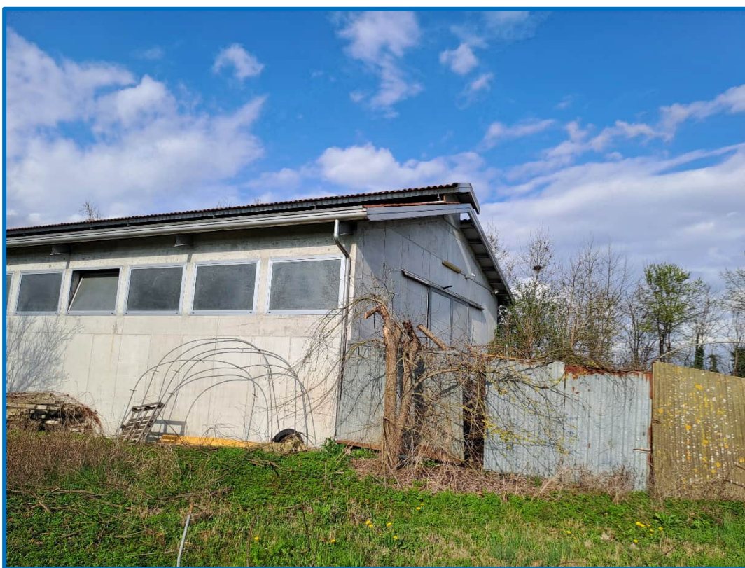
n° 2 Esterno capannone sud-ovest
