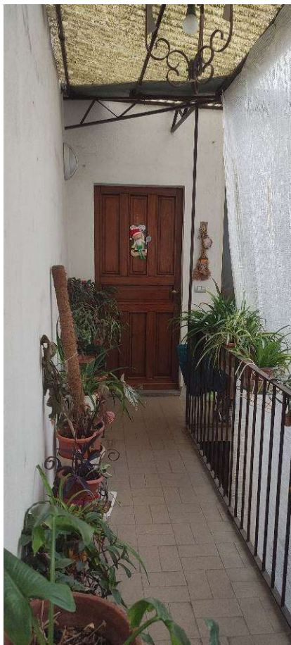
Portoncino ingresso appartamento
