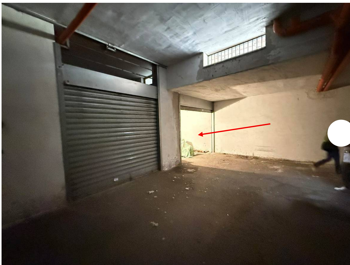
Foto 28 - Il sub 204 dall'area comune di manovra sub 11
