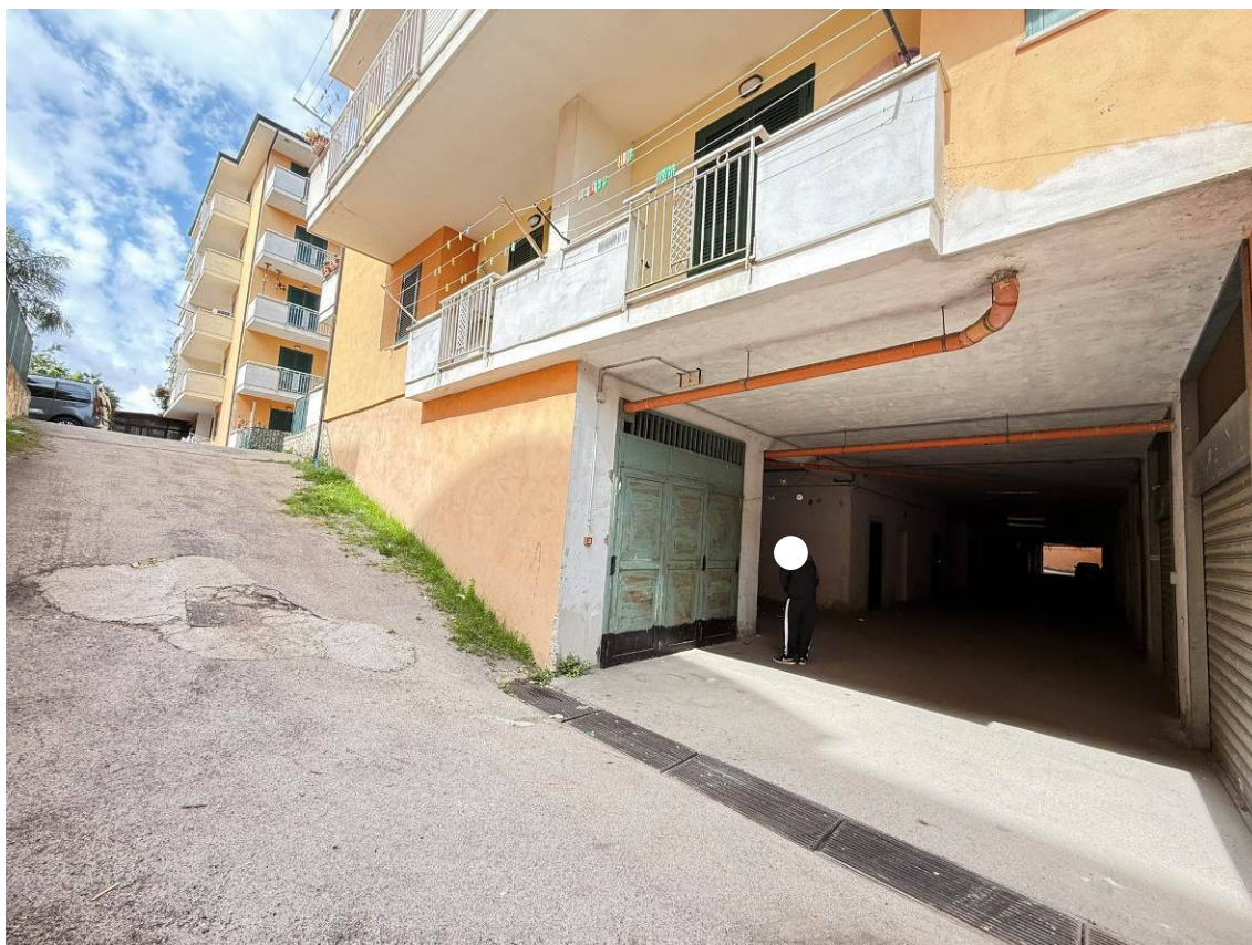
Foto 25 - Ingresso ai box auto piano seminterrato
