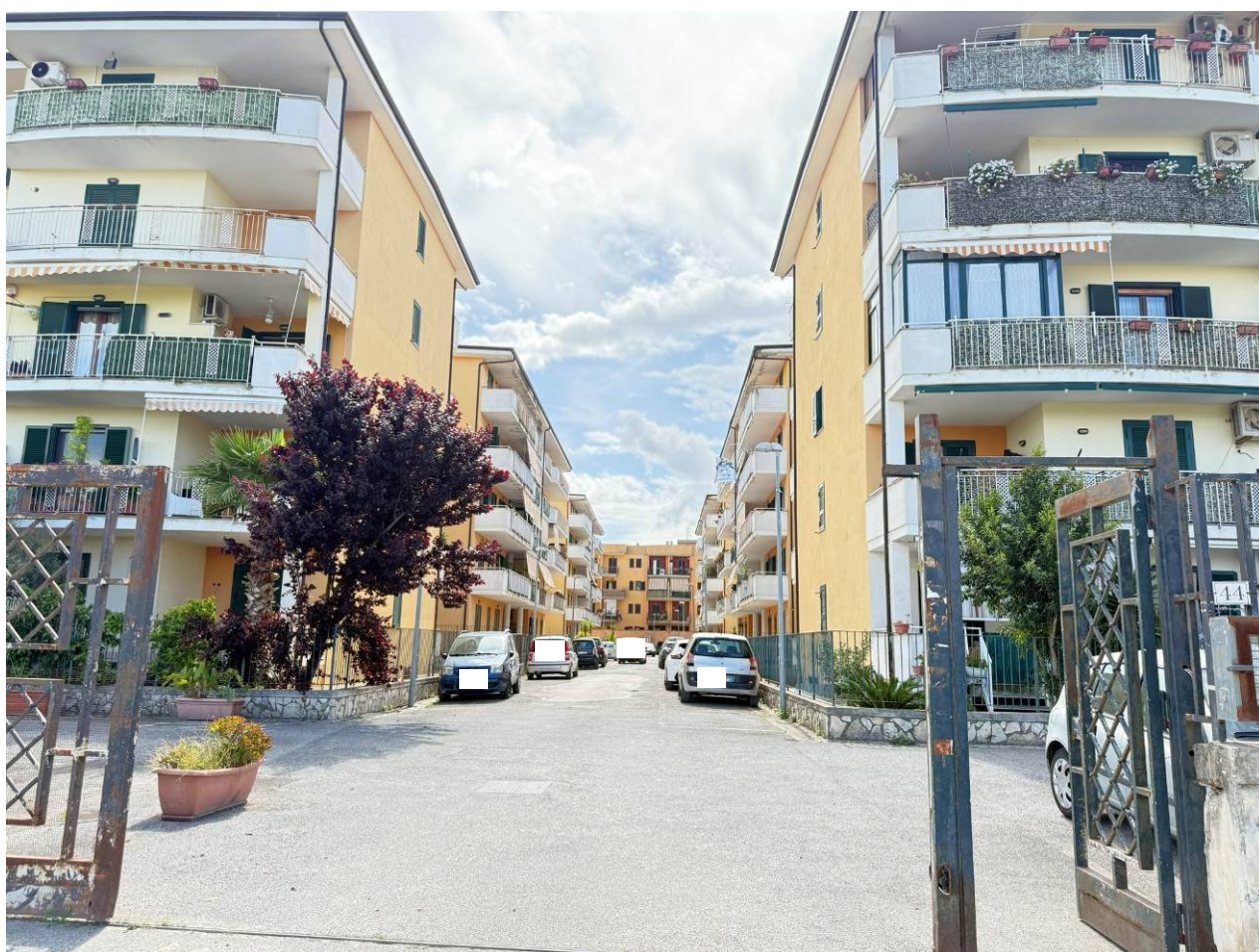
Foto 02 – Il viale interno al complesso immobiliare
