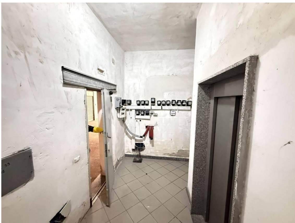
Foto 26 - Scale comuni al piano seminterrato
