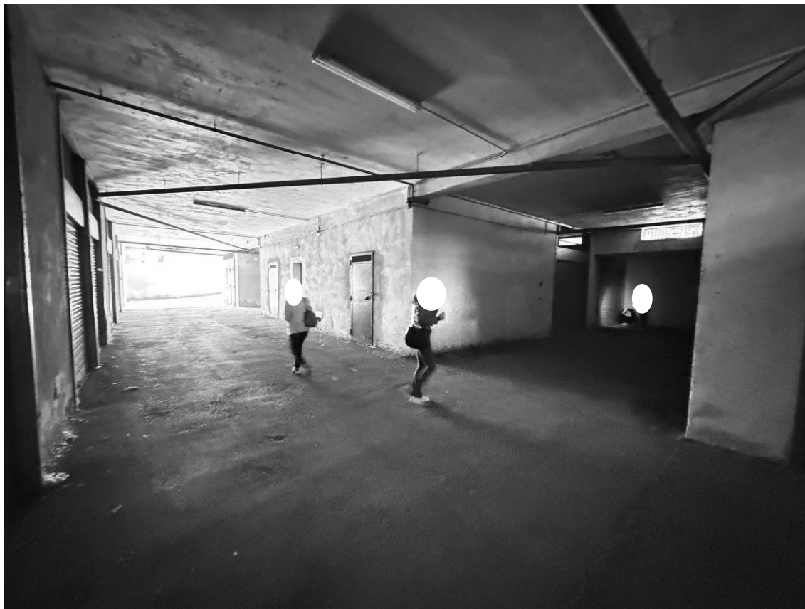
Foto 27 - Area comune di manovra sub 11
