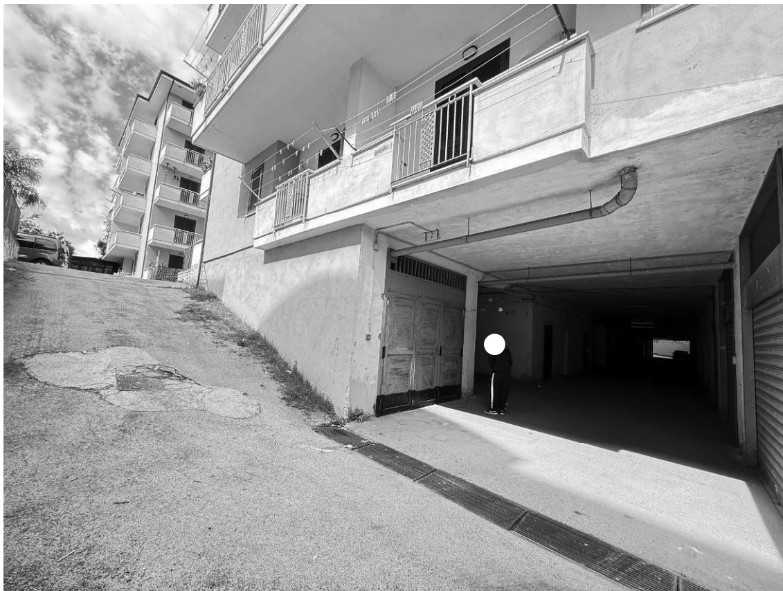
Foto 25 - Ingresso ai box auto piano seminterrato
