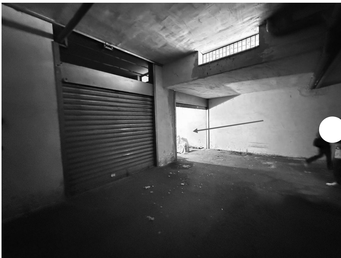
Foto 28 - Il sub 204 dall'area comune di manovra sub 11
