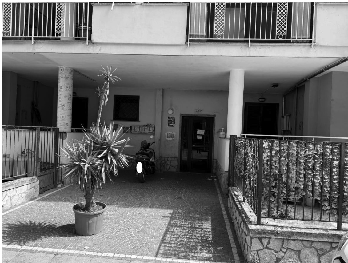
Foto 04 – L'ingresso alla scala F
