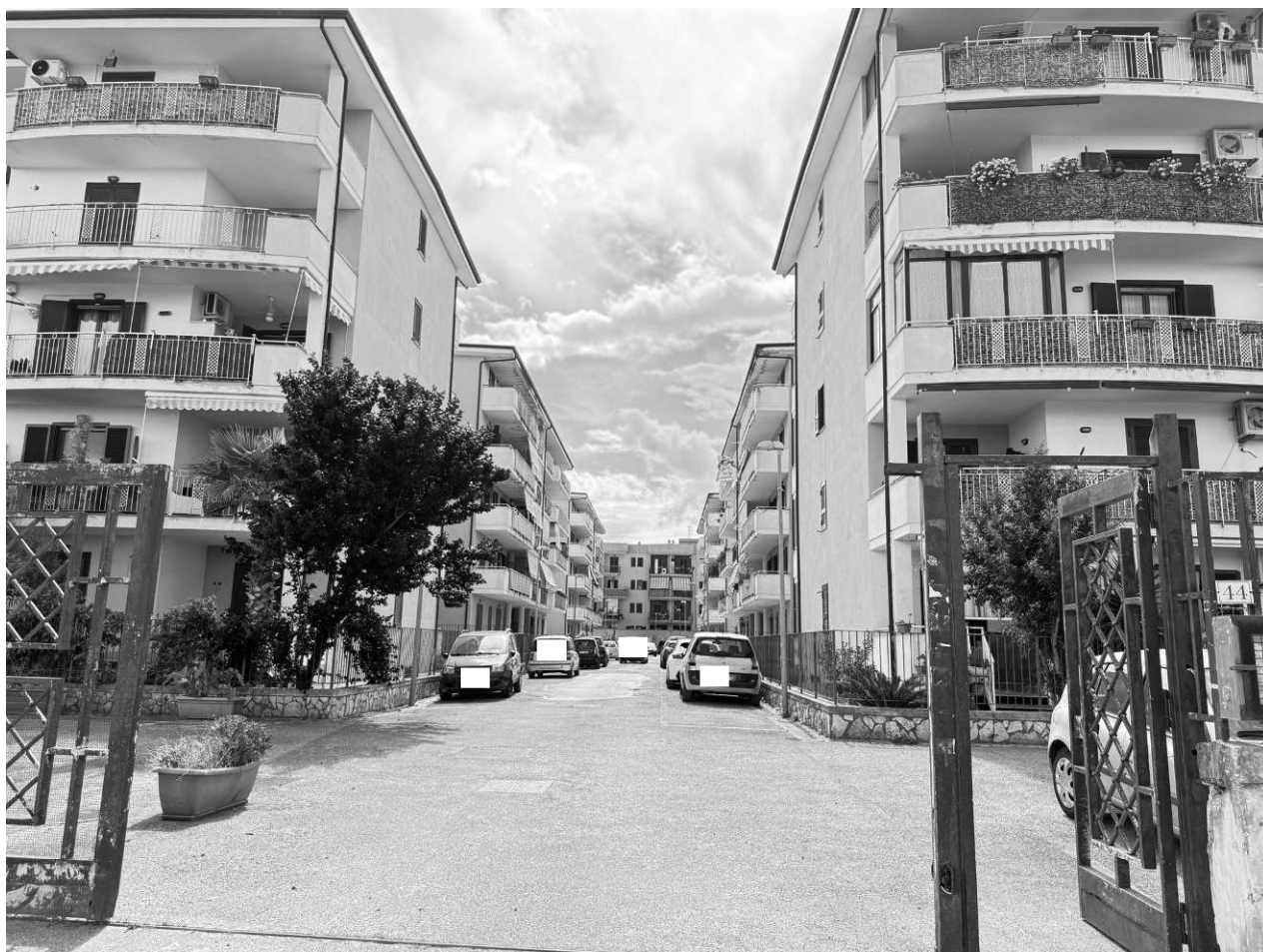
Foto 02 – Il viale interno al complesso immobiliare
