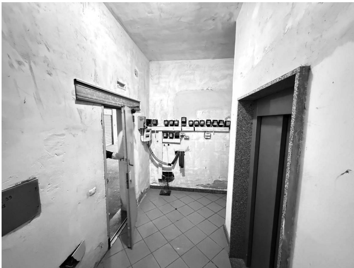
Foto 26 - Scale comuni al piano seminterrato
