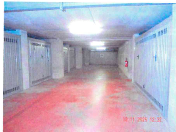
Area di manovra
