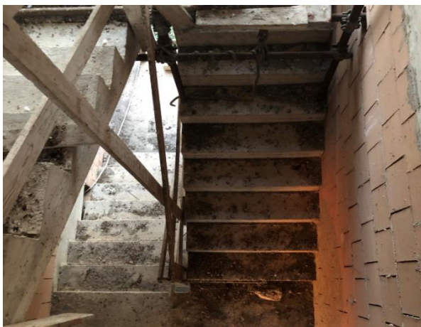
13 Vano scala al grezzo
