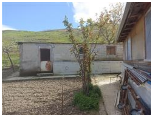
Part. 221 (deposito, pollaio, porcilaia), esterno
