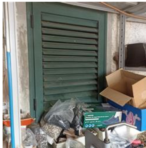
Part. 91, sub. 2. La finestra del bagno, che non affaccia più su spazio esterno, ma sulla veranda ad uso laboratorio collegata al sub. 1
