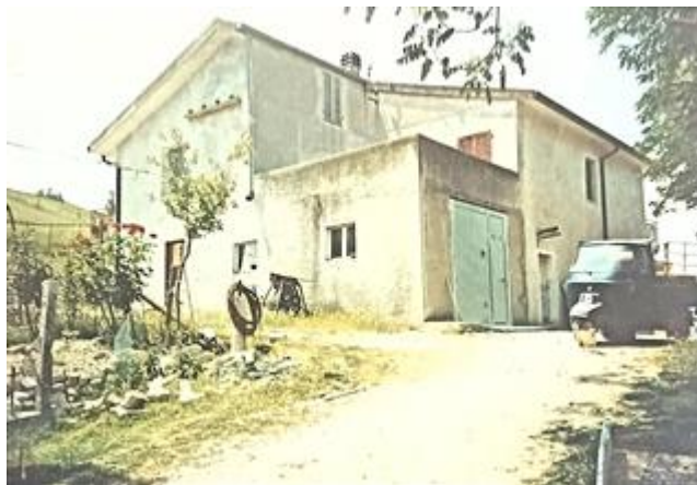
Part. 91. La sagoma originaria del fabbricato, in una foto non successiva al 1997; i fori e il posatoio nel muro indicano un possibile utilizzo del sottotetto, in passato, come colombaia
