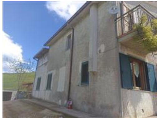
Part. 91, sub. 2. La facciata a valle
