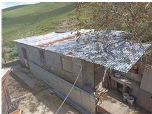
Part. 221 (deposito, pollaio, porcilaia), esterno
