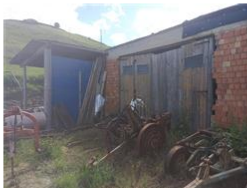
Part. 220 (deposito, stalla, rimessa attrezzi), esterno
