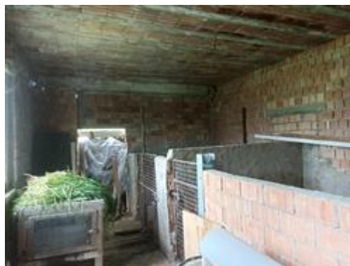
Part. 220 (deposito, stalla, rimessa attrezzi), l'ambiente interno, con alcune spallette per delimitare i box per gli animali
