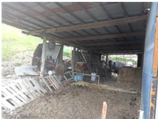
Part. 220 (deposito, stalla, rimessa attrezzi), la parte a monte, interessata dall'evento franoso
