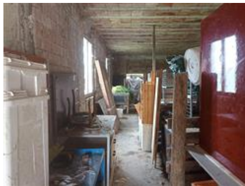
Part. 220 (deposito, stalla, rimessa attrezzi), l'ambiente interno, in origine destinato a ovile
