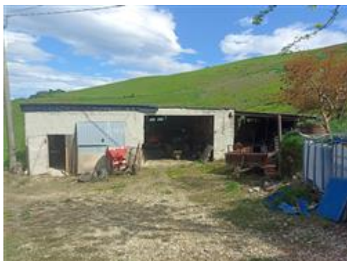
Part. 220 (deposito, stalla, rimessa attrezzi), esterno
