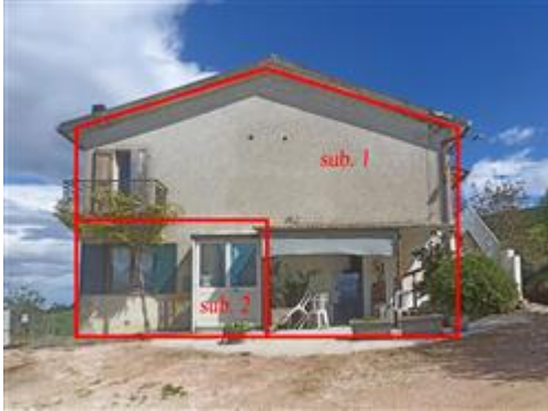
Part. 91. La facciata dell'ingresso; l'immobile di interesse è posto al piano terra (parte destra) e al piano primo (Part. 91, sub. 1); corrisponde al civ. 4
