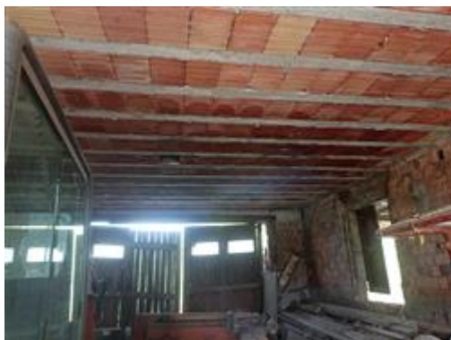
Part. 220 (deposito, stalla, rimessa attrezzi), l'ambiente interno, in origine destinato a ovile
