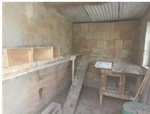
Part. 221 (deposito, pollaio, porcilaia), interno
