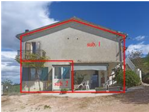
Part. 91. La facciata dell'ingresso; l'immobile di interesse è a sinistra, a piano terra (Part. 91, sub. 2); corrisponde al civ. 2
