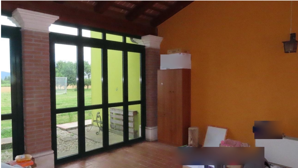
Foto 5 – Annesso rustico interno
