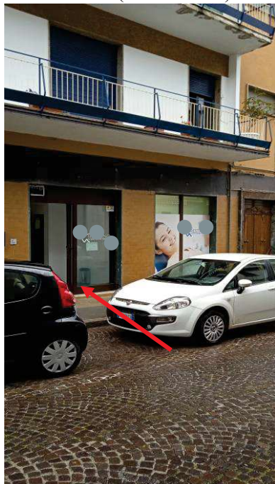
Foto esterna (via Marconi)
