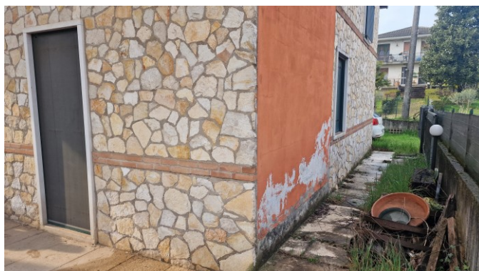
ESTERNO LATO EST
