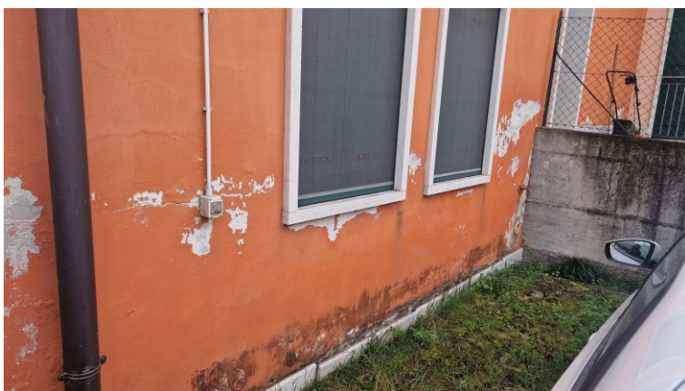
ESTERNO LATO NORD
