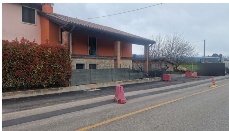
PROSPETTO SUD CON PISTA CICLABILE IN FASE DI REALIZZO
