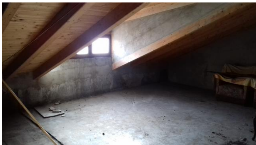
Sottotetto lato sud/est
