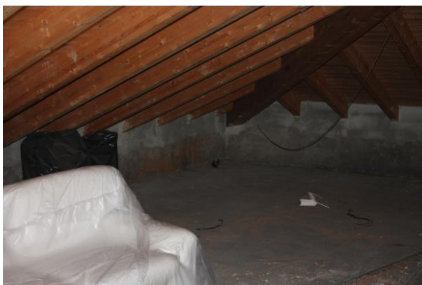
Sottotetto lato nord/ovest
