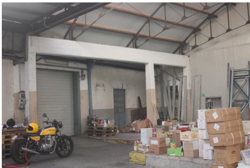
Deposito zona tettoie
