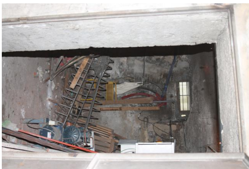
Cantina lato nord/est
