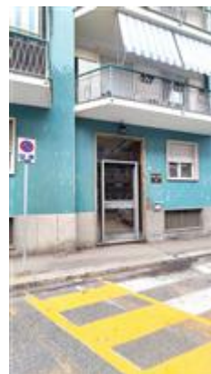
Portoncino di ingresso di via Sestriere n.29
