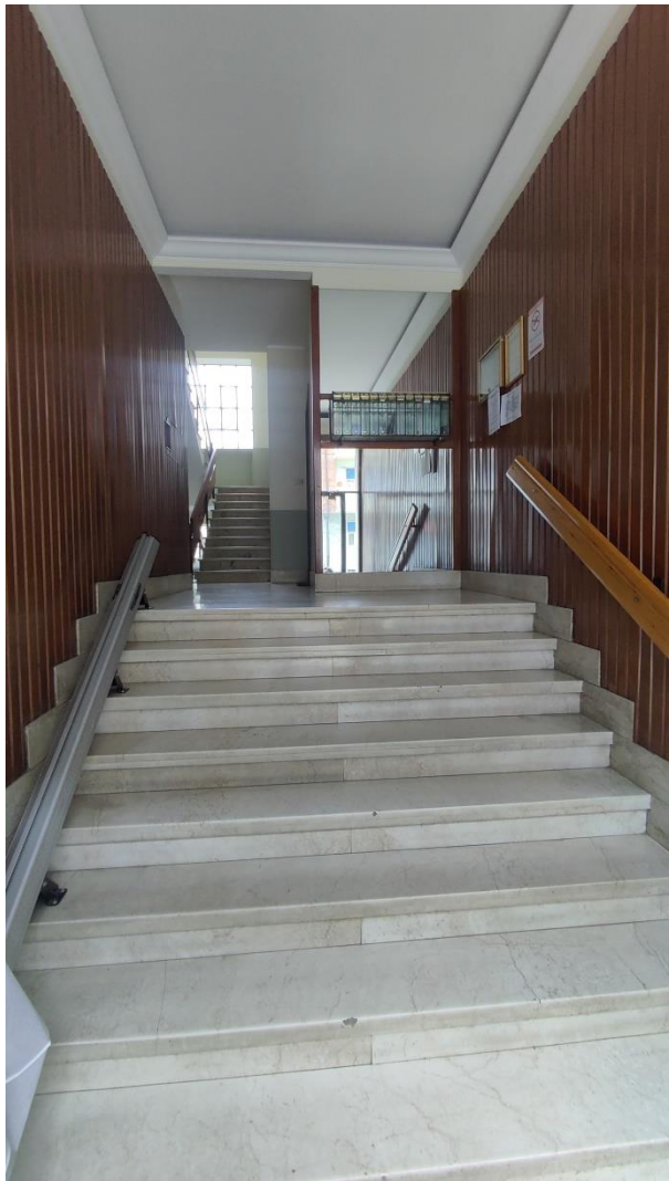
Foto androne e vano scala condominiale:
