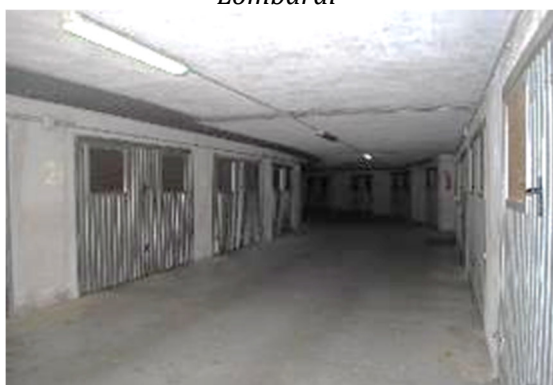
Foto 4 – corsia di manovra
