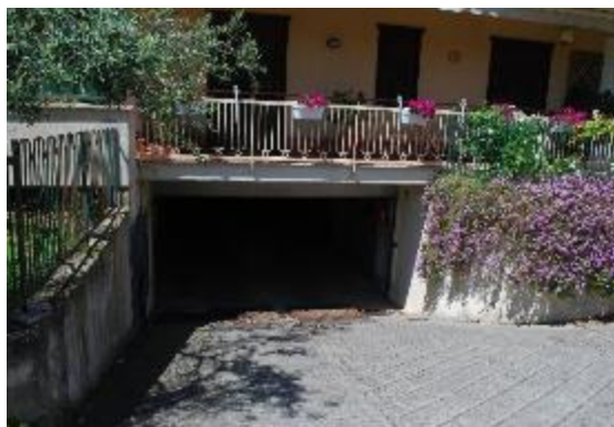
Foto 2 – ingresso posto su via Capo Casale Lombardi
