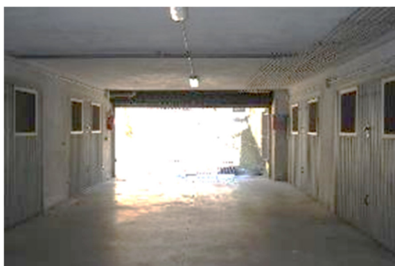
Foto 3 – ingresso posto su via Capo Casale Lombardi
