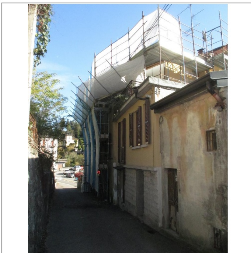
- Complesso condominiale - Fronti nord e ovest -
