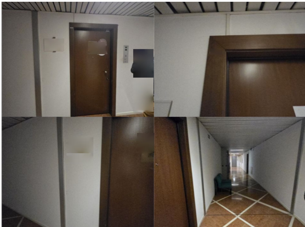
Fig.6-Porta blindata-pannello esterno finitura legno di noce- di accesso all'ufficio;
