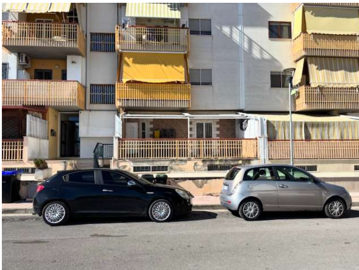
Foto n. 2 – Prospetto dell'ingresso condominiale dal civico 9 di Via Bellini
