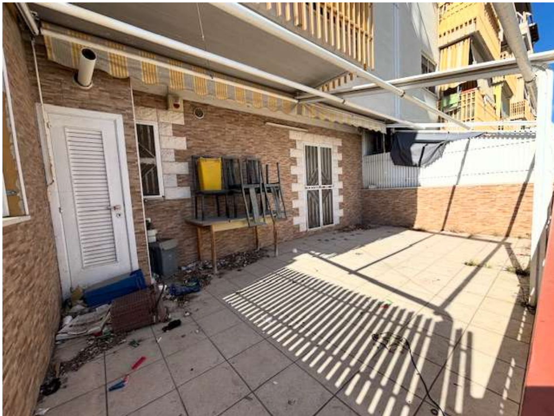
Foto n. 19 – Veranda esterna scoperta sul prospetto di Via Bellini
