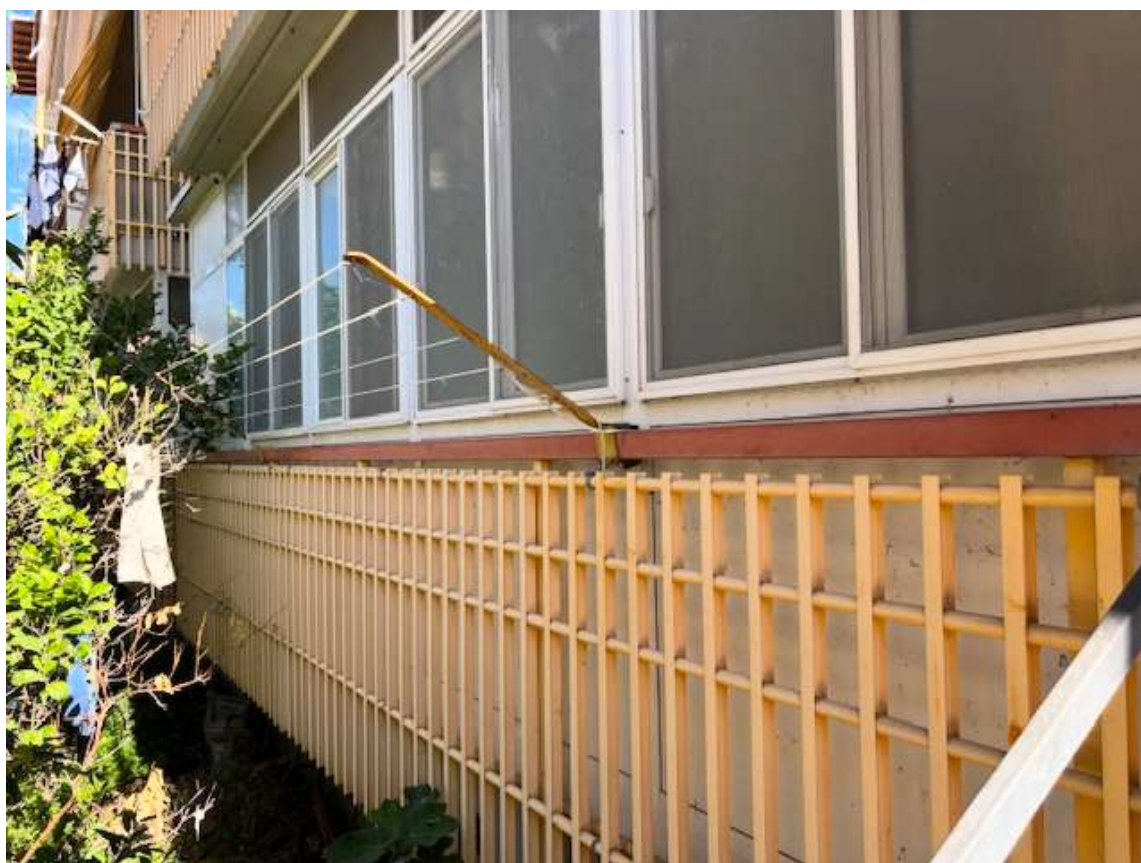
Foto n. 18 – Balcone e veranda sul prospetto di Via Cimarosa
