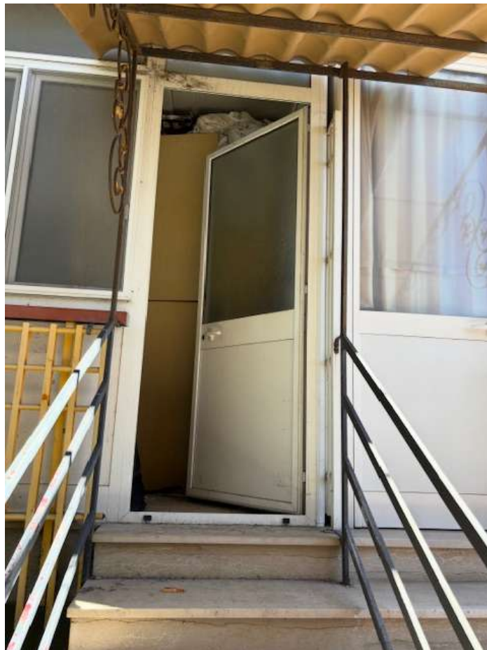
Foto n. 17 – Porta e scala di accesso dall'appartamento al giardino esclusivo su Via Cimarosa
