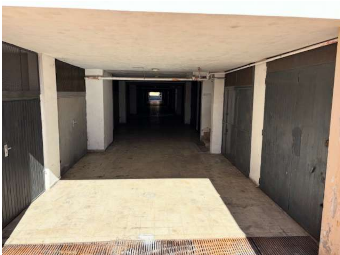
Foto n. 24 – Corsia di manovra condominiale (in fondo 2° accesso condominiale)
