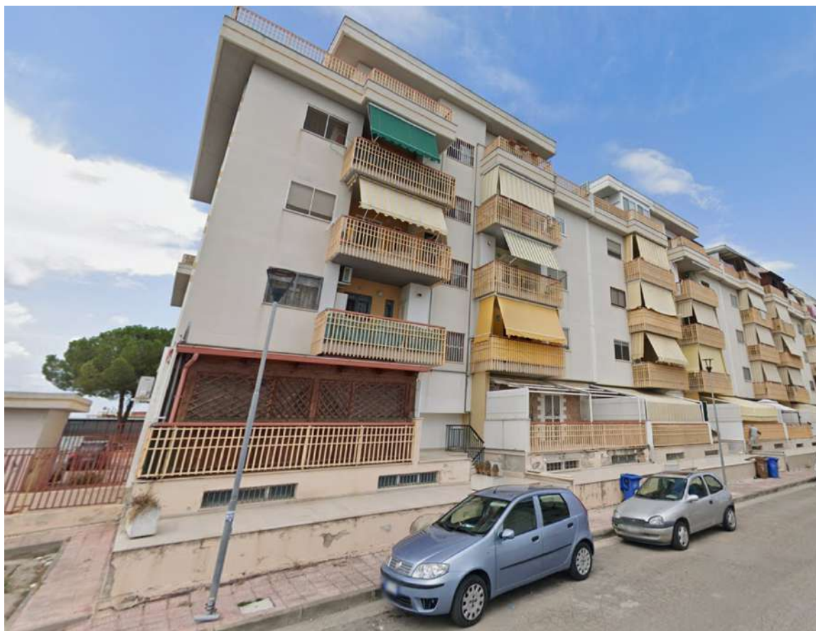
Foto n. 1 – Fabbricato condominiale di Via Bellini
