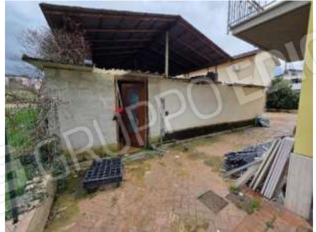
Figura 13 - Locale esterno lato ovest
