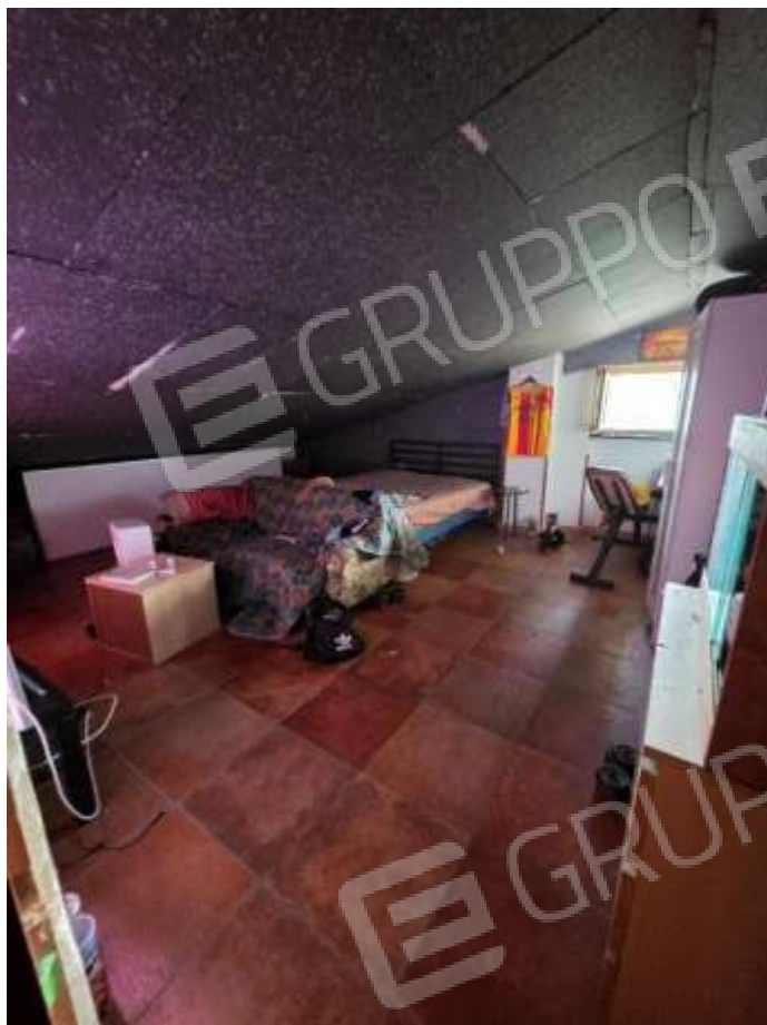
Figura 79- Vano sottotetto lato OVEST
