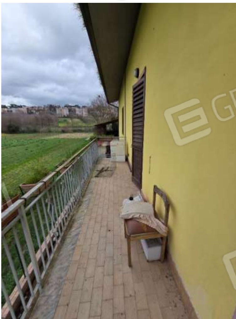
Figura 54 - Balcone cucina affaccio lato ovest u.i. p.p.
