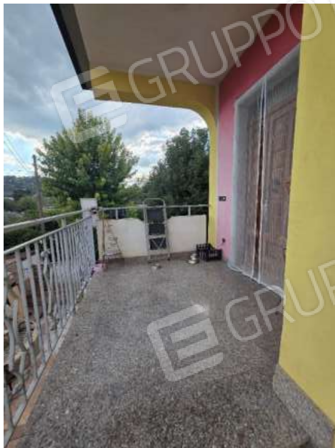
Figura 44 - Pianerottolo u.i. primo piano
