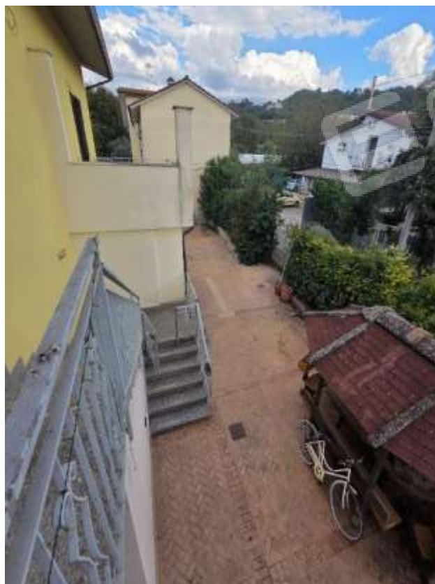
Figura 45 - Pianerottolo u.i. primo piano
