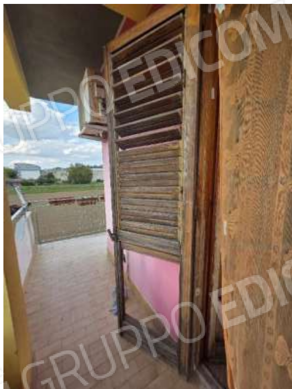
Figura 53 - - Balcone cucina affaccio lato ovest u.i. p.p.
