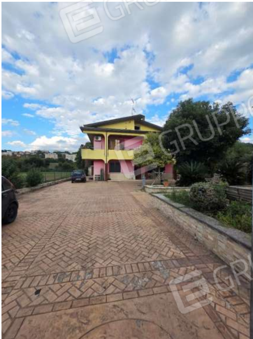
Figura 1 - Ingresso cancello principale
