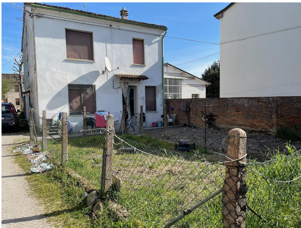
Fronte arretrato su via Co' de Belli 43 (mappale 28 subalterno 2).
