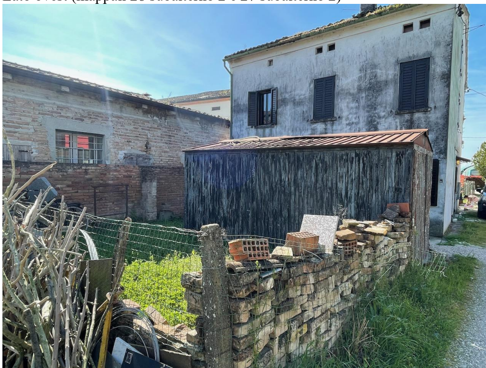
Retro dell'abitazione (mappale 22 subalterno 2) con autorimessa (mappale 27 subalterno 3 ) in lamiera ondulata .
