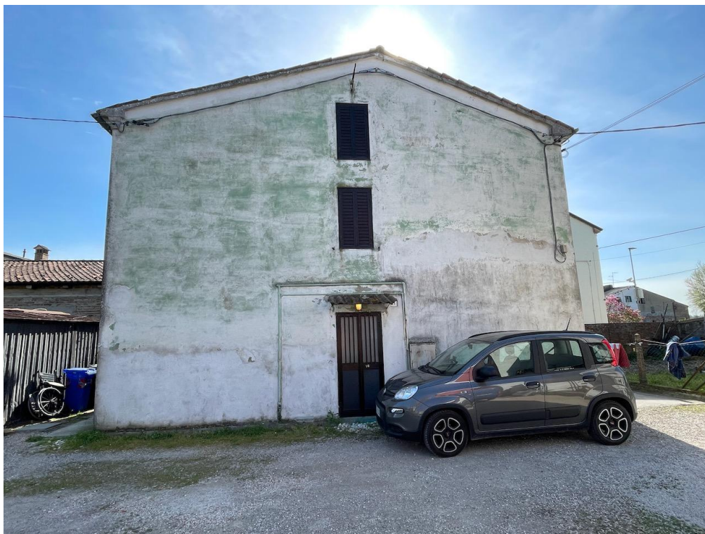
Lato ovest (mappali 28 subalterno 2 e 27 subalterno 2)
