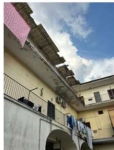
Foto n. 5 - Interno cortile del fabbricato
