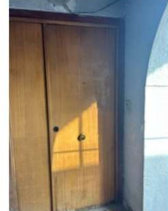
Foto n. 8 - Ingresso all'immobile pignorato dal vano scala
