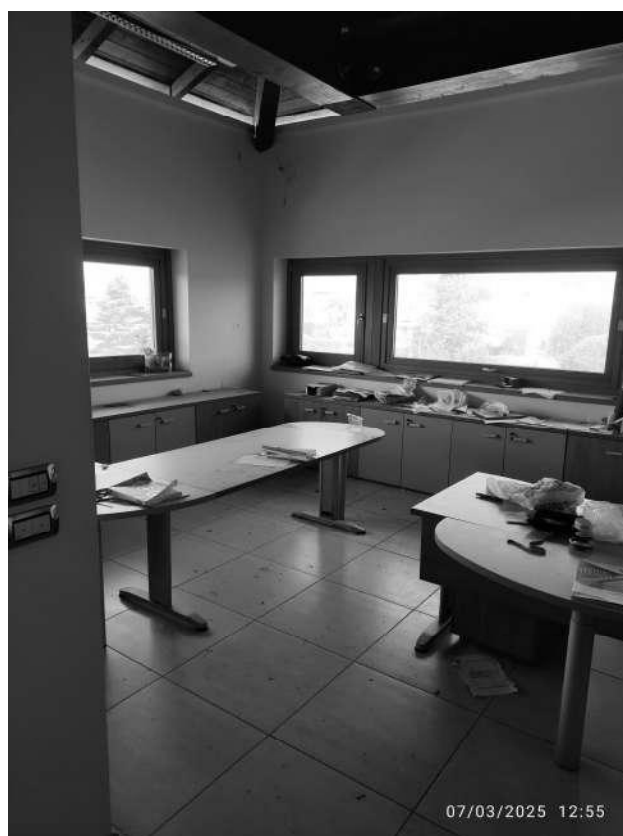
Foto n°32: Vista ufficio piano terzo
