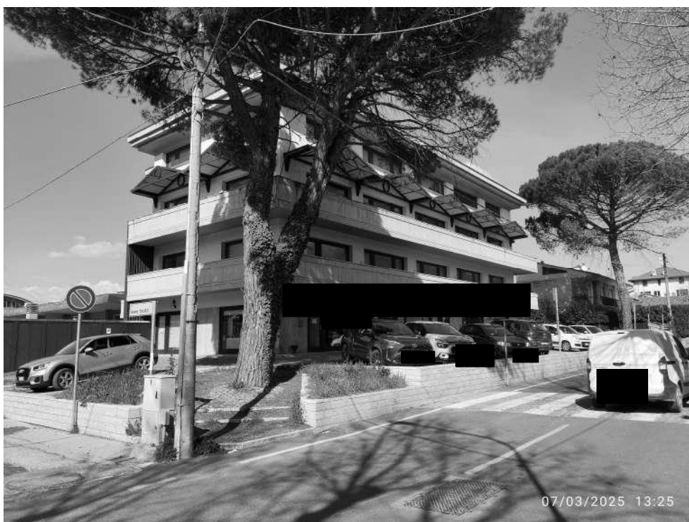
Foto n° 6: Vista esterna corte esterna condominiale con parcheggio privato ad uso pubblico
