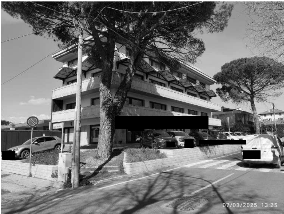
Foto n° 2: Vista esterna Via Leone Tolstoj angolo Via del Pino
