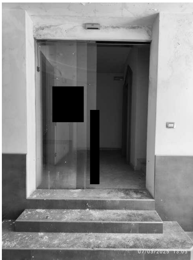
Foto n° 10: Ingresso condominiale con scala ed ascensori interni
