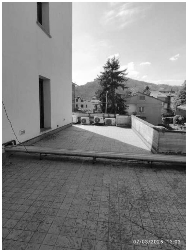
Foto n° 14: Terrazzo condominiale al piano primo per posizionamento impianti
