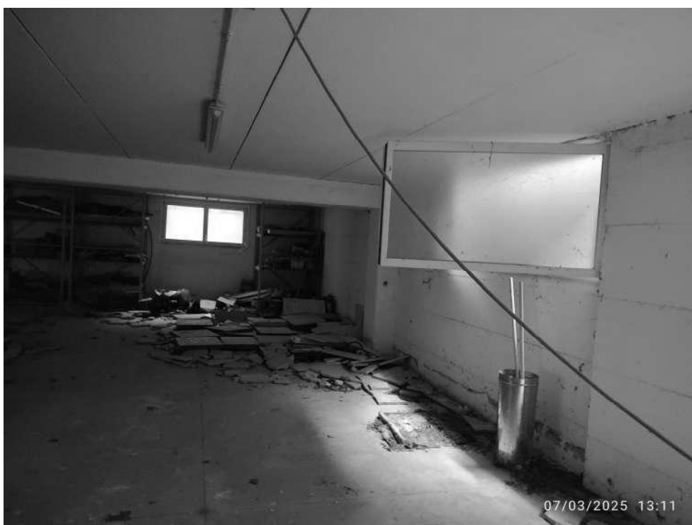
Foto n°20: Vista autorimessa con bocche di lupo
