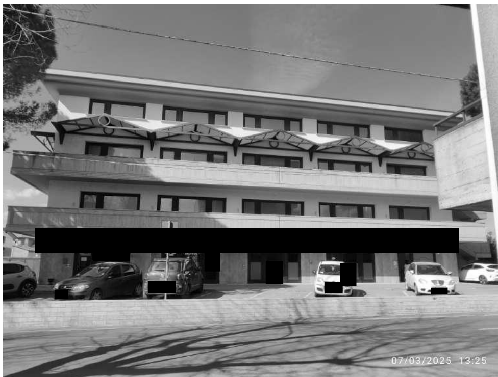
Foto n° 3: Vista esterna Via del Pino
