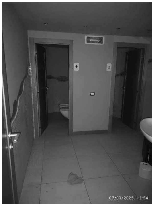
Foto n°35: Vista bagni ufficio piano terzo
