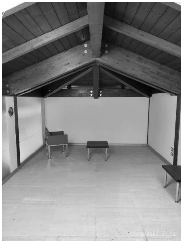
Foto n°37: Vista ufficio piano soppalco
