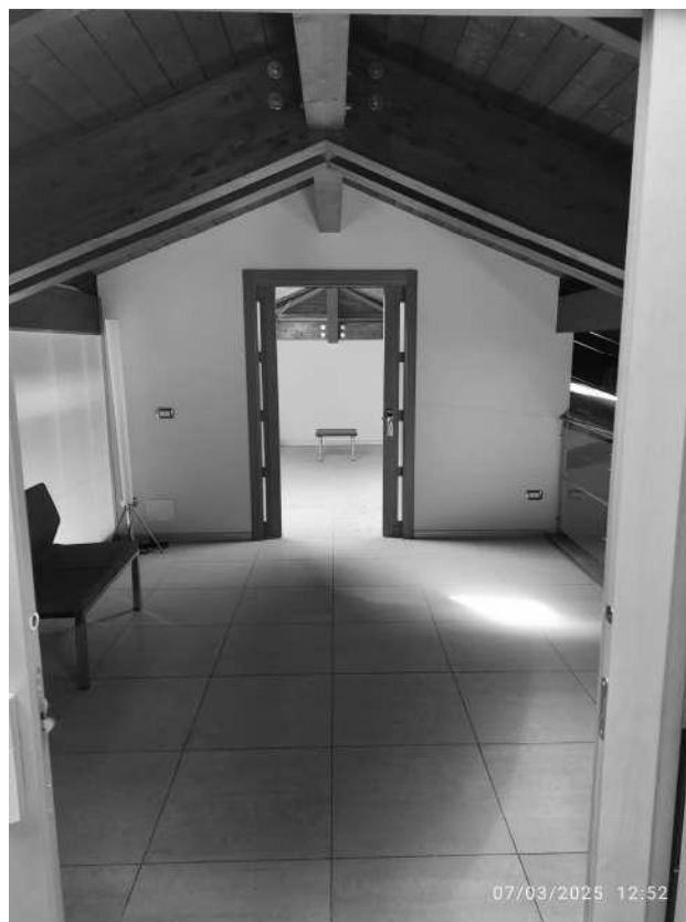
Foto n°38: Vista ufficio piano soppalco
