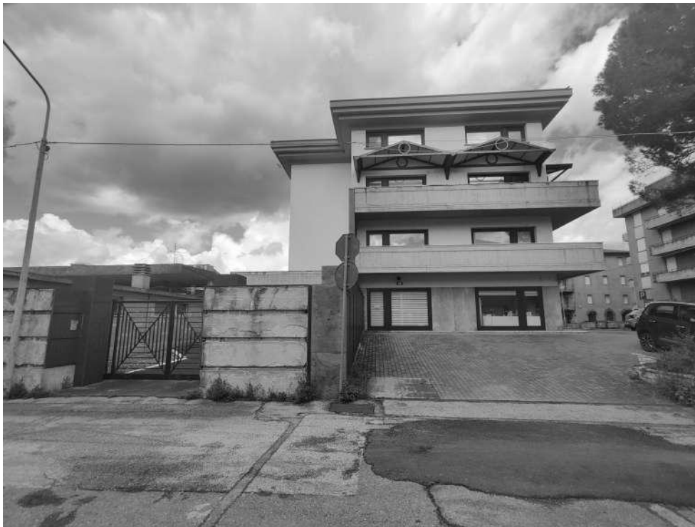
Foto n° 1: Vista esterna Via Leone Tolstoj
