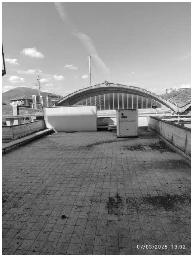
Foto n° 15: Terrazzo condominiale al piano primo per posizionamento impianti
