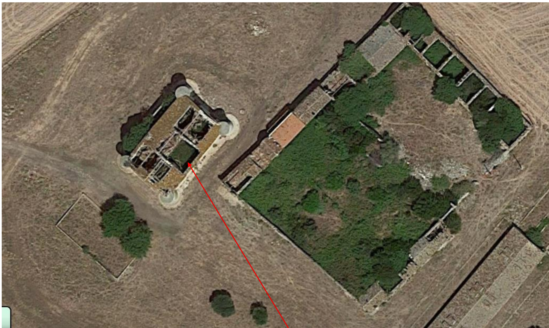
Particolare aereo fabbricato
