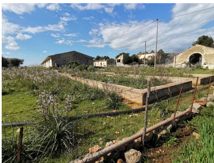
L'aia comune in p.lla 563 – (questa parte di fabbricati sono stati assegnati a terzi)
