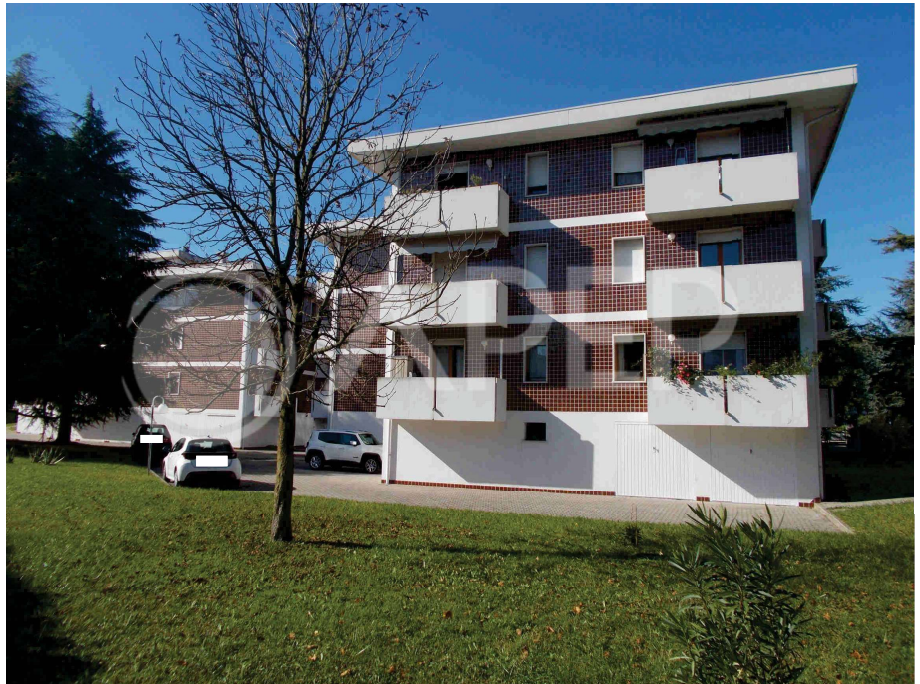
Foto 1- Vista esterna da est
