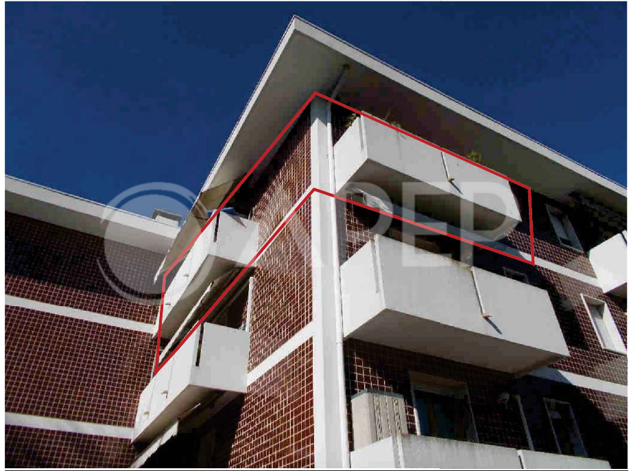
Foto 3- Vista esterna- angolo sudest
