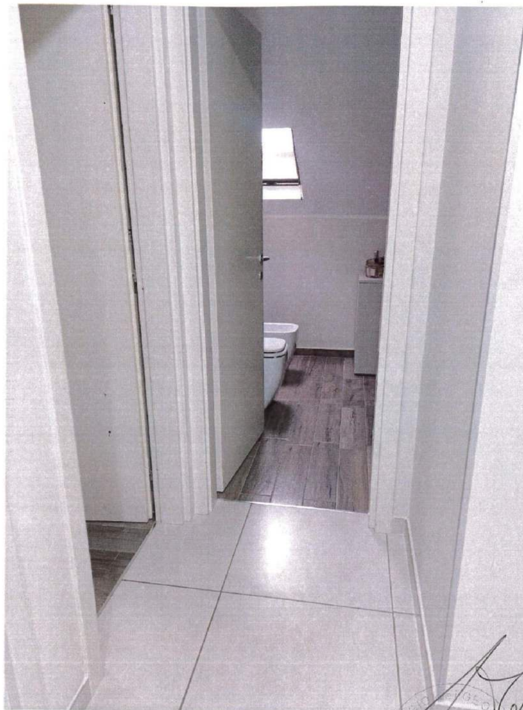
FOTO N° 3 - VISTA INTERNA DELL'APPARTAMENTO (SERVIZIO IGIENICO)
