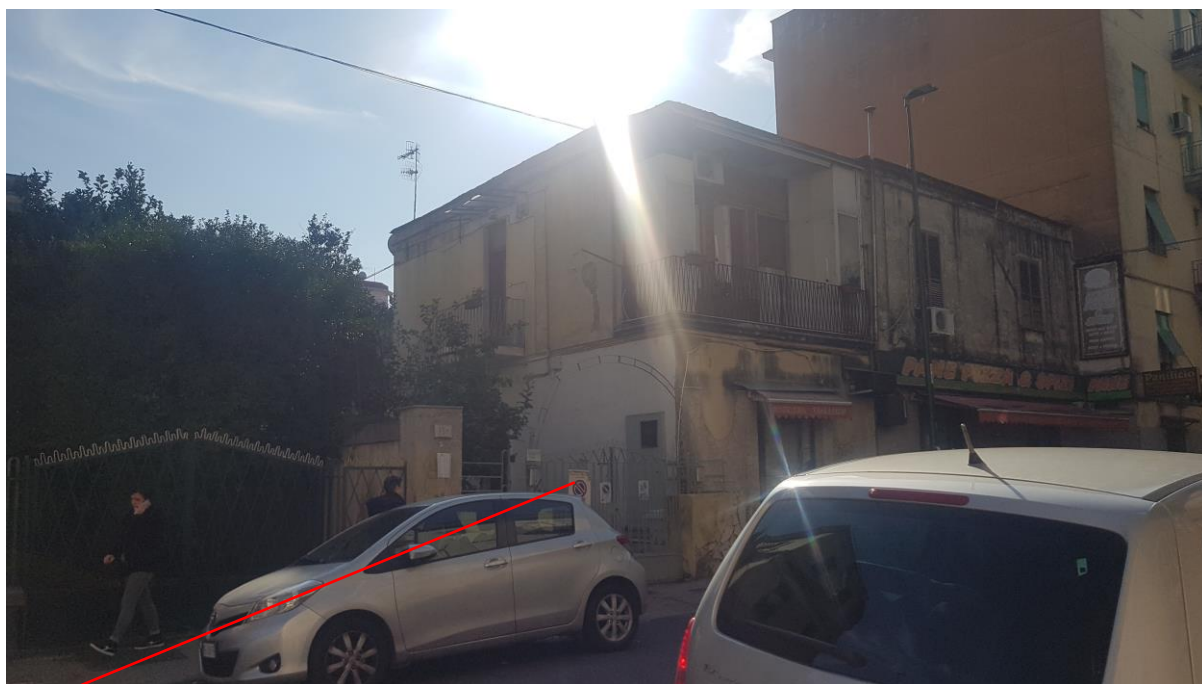
Accesso al fabbricato sito in Napoli – Via Monviso n.25/bis
