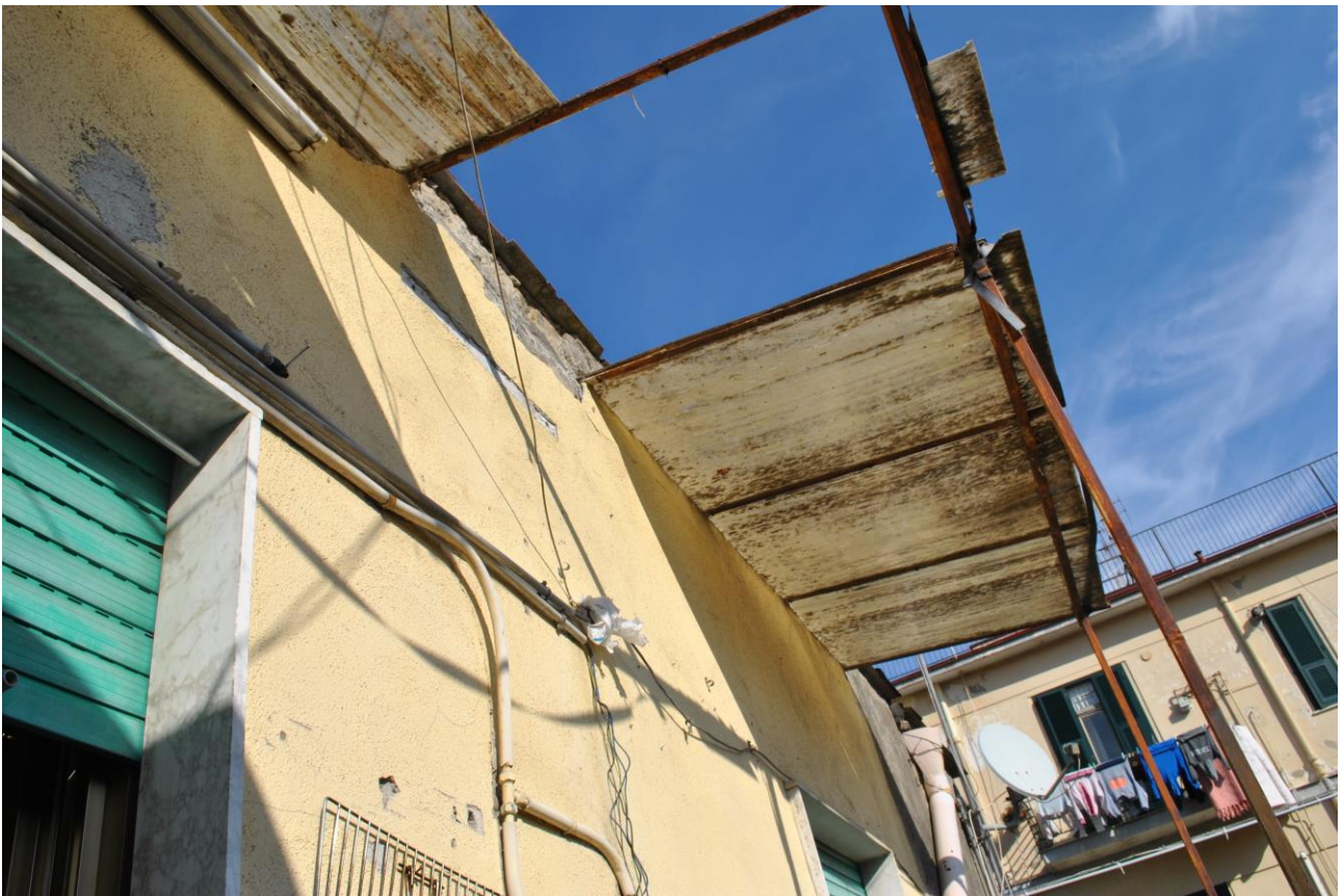
Particolare della tettoia posta a copertura del terrazzino (T)
