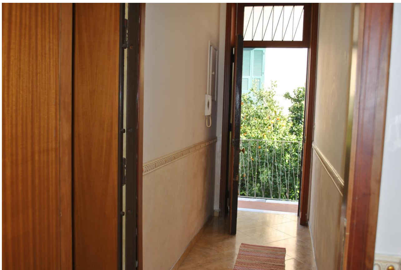
Accesso all'area comune tra i subalterni 5 e 6
