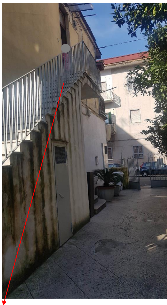
Rampa di accesso
