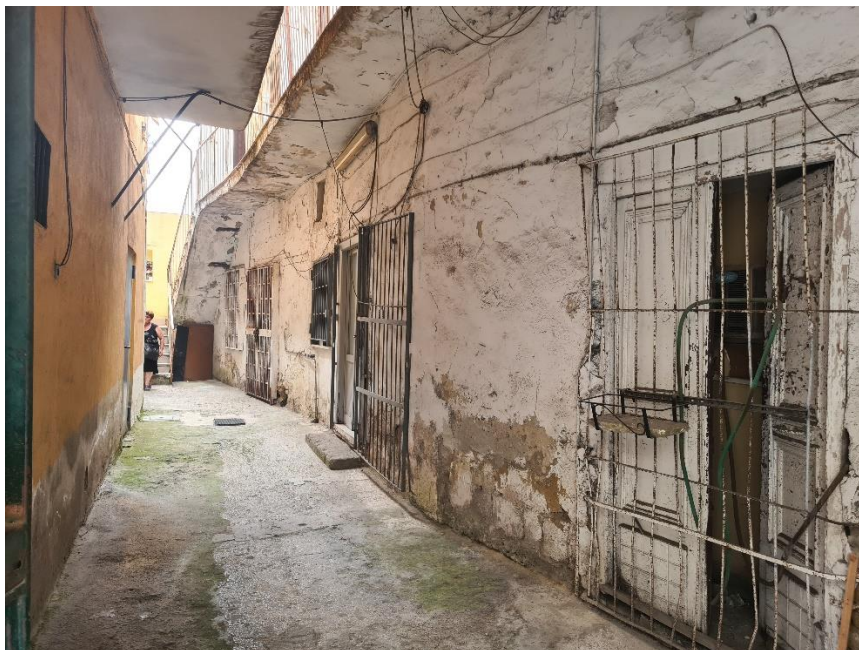
Vista esterna dall'ingresso del piano terra verso il vialetto interno
