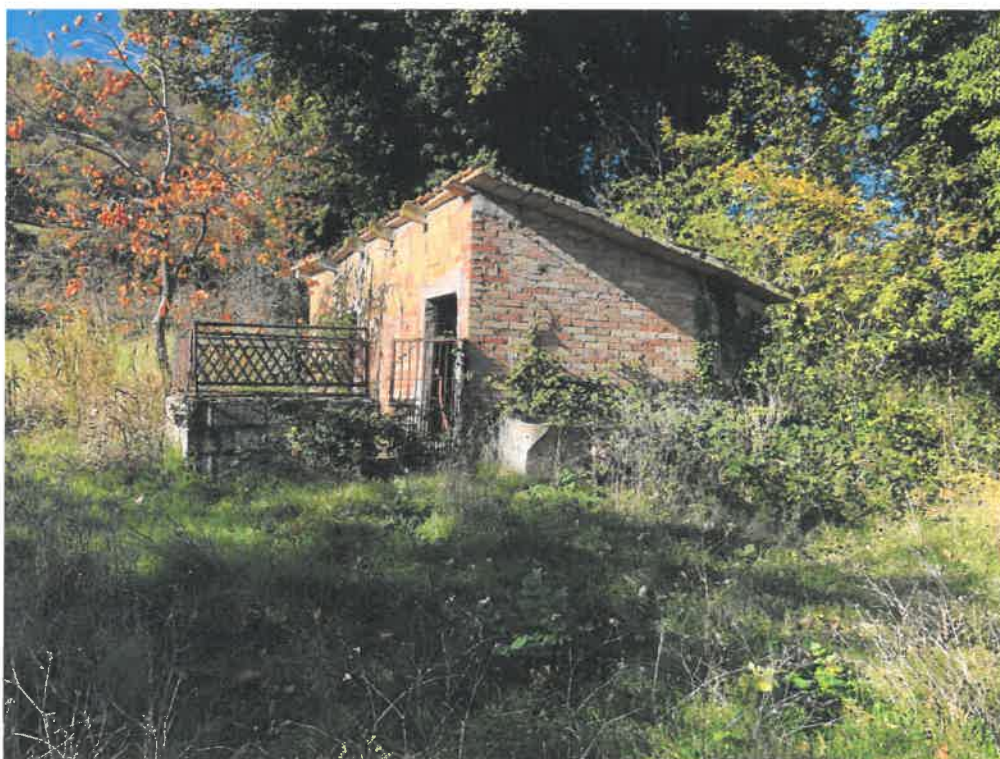
Foto 11 – Annesso 2 (da demolire)
