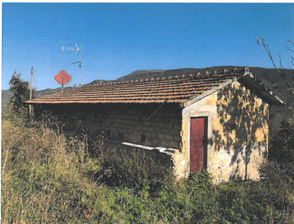
Foto 08 – Annesso 1 (esterni - piano terra da demolire)
