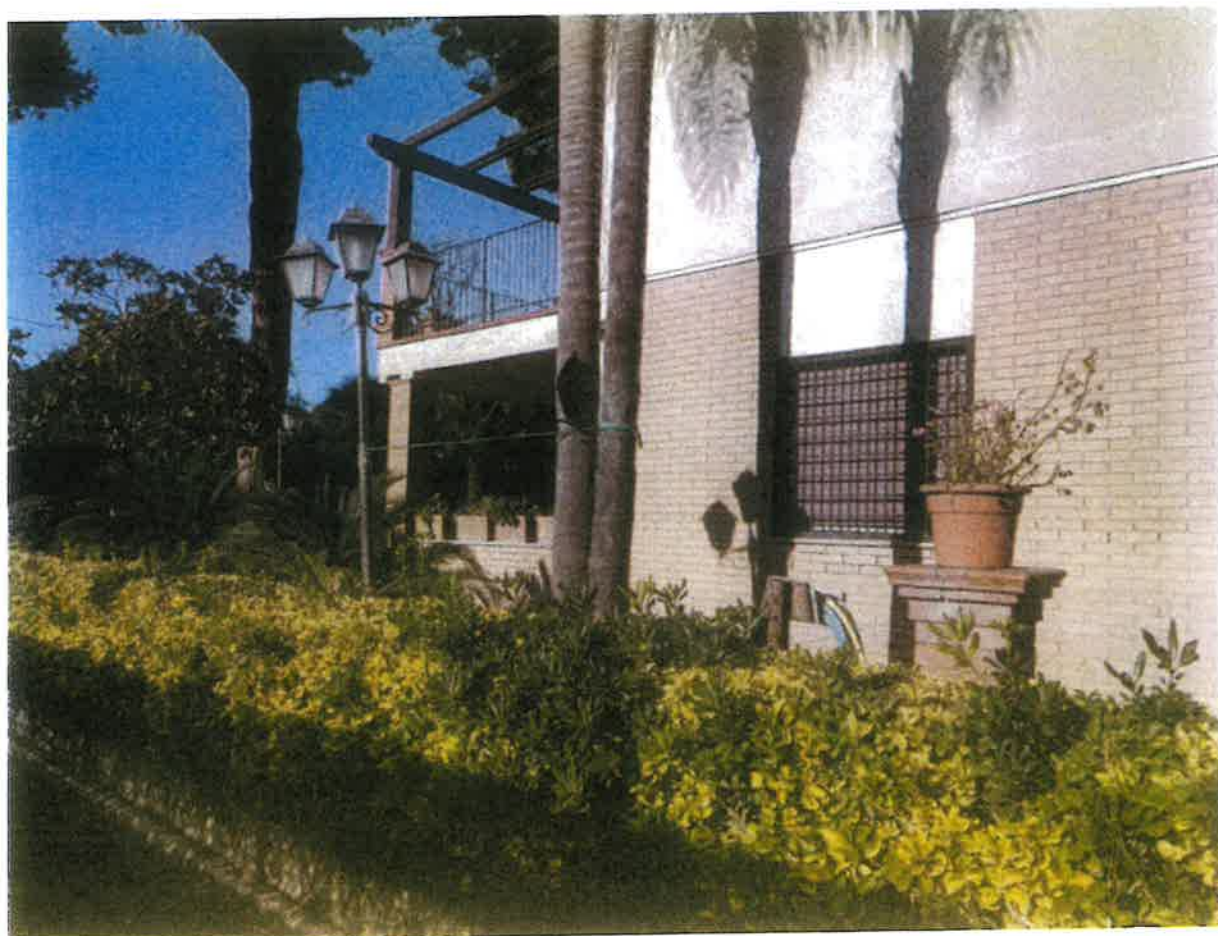
PIANO TERRA – VISTA ESTERNA LATO STRADELLO ACCESSO AUTORIMESSA
