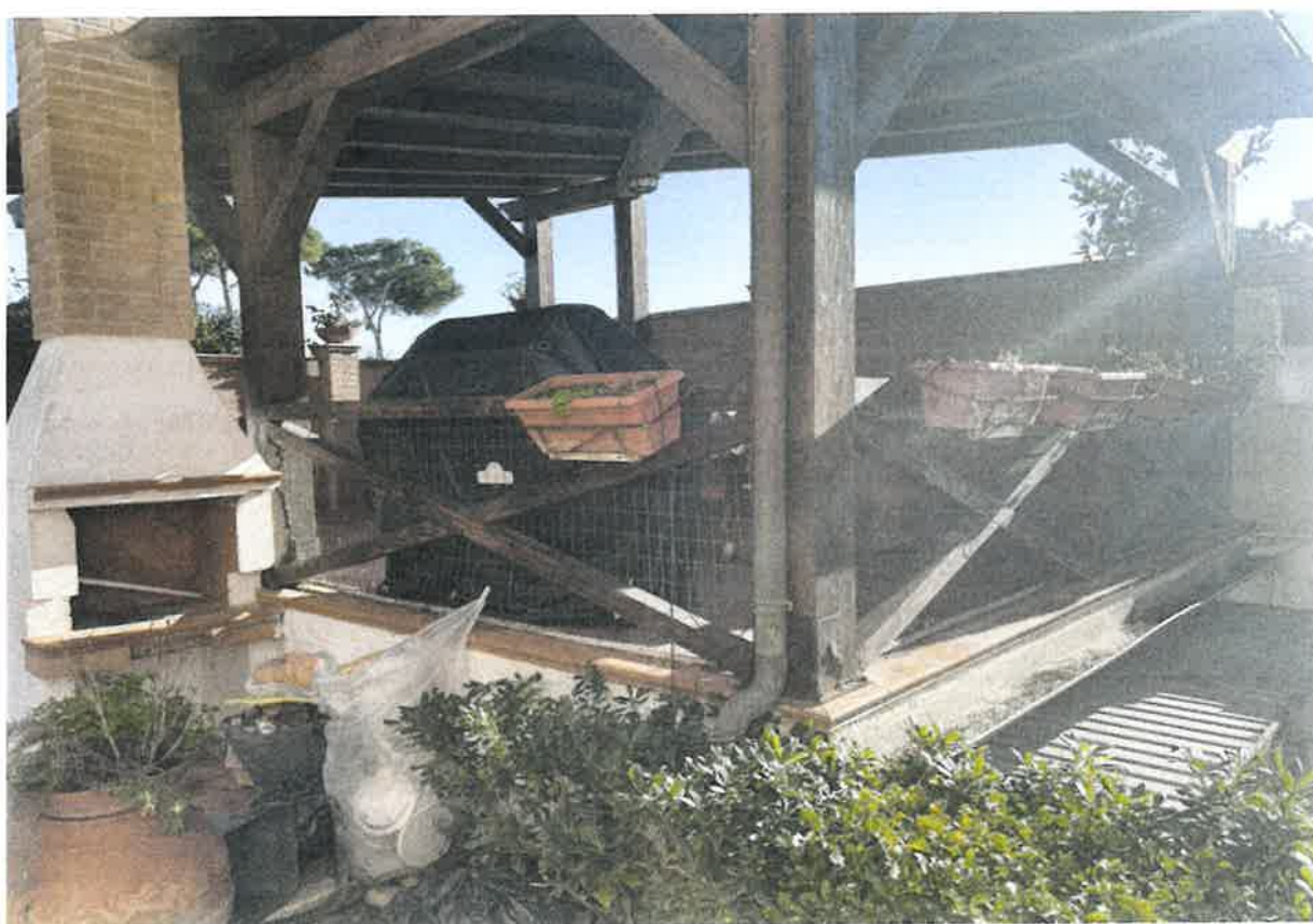
TETTOIA REALIZZATA SUL SOLAIO AUTORIMESSA
