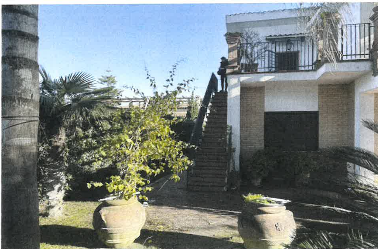
PIANO PRIMO E TERRA – SCALA ACCESSO PIANO PRIMO
