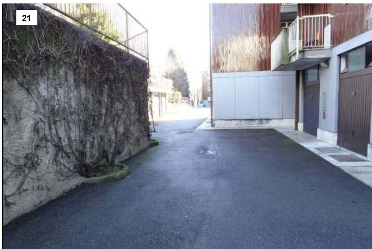
STRADELLO INTERNO ACCESSO BOX E RETRO EDIFICIO (visto verso esterno)
