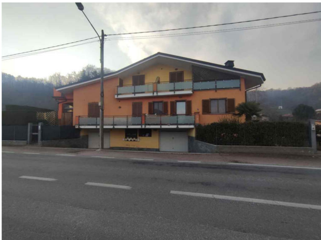
Prospetto del condominio dalla strada provinciale
