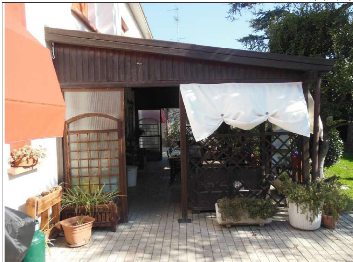
PROSPETTO POSTERIORE DEL FABBRICATO – PERGOLATO
