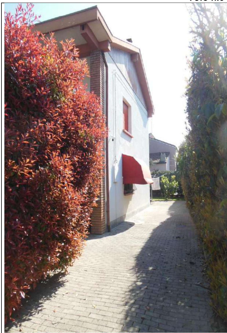
PROSPETTO LATERALE DEL FABBRICATO
