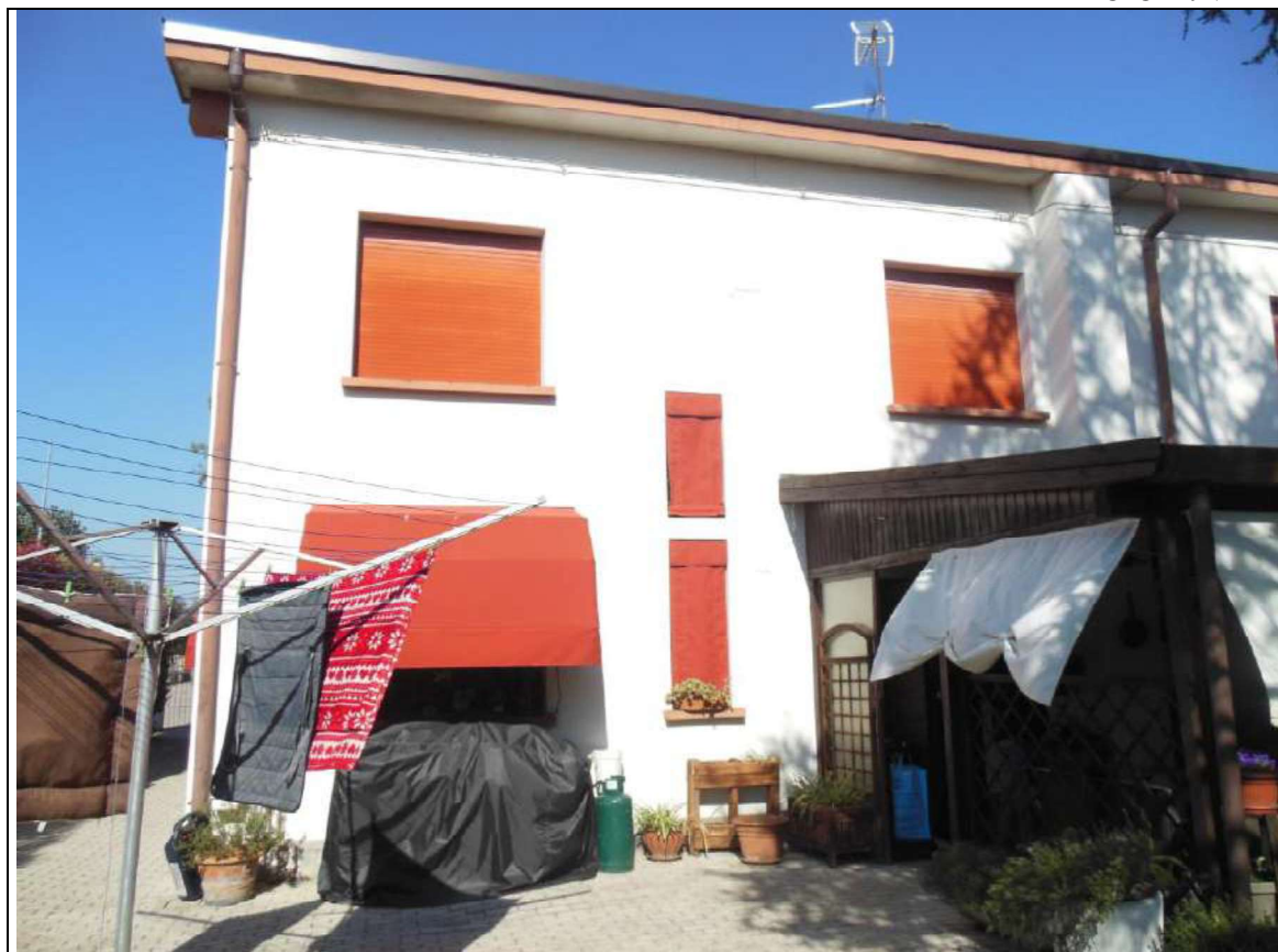
PROSPETTO POSTERIORE DEL FABBRICATO
