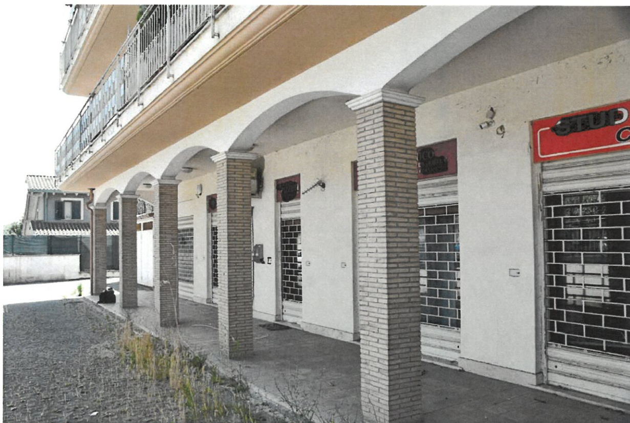
Particolare dell'unità immobiliare adibita ad uffici Lotto 2
