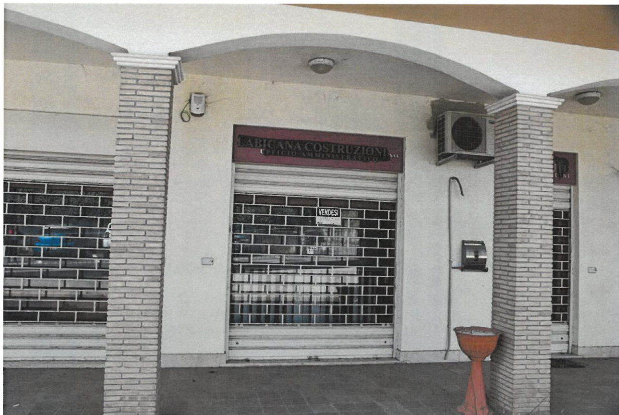
Particolare dell'unità immobiliare adibita ad uffici Lotto 2
