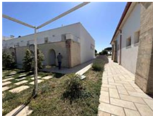
Stato di fatto marciapiedi prospetto a sud
