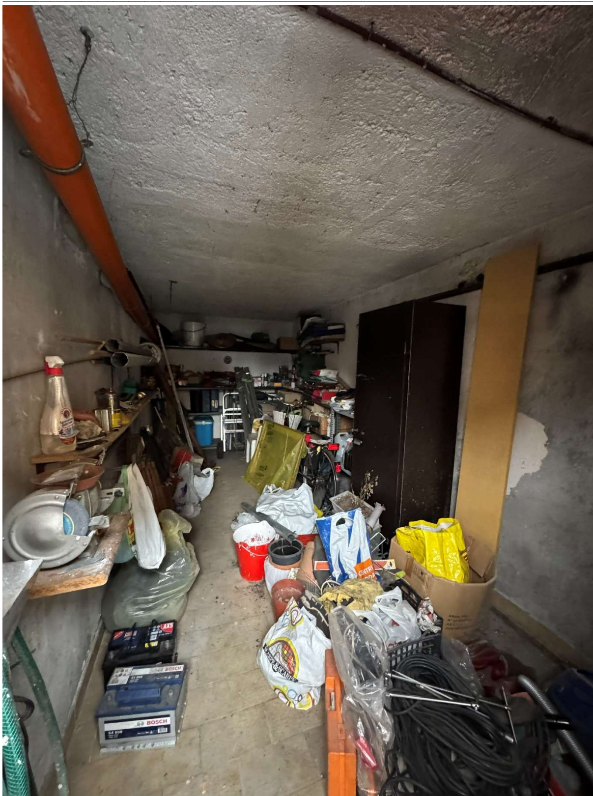
Foto n. 37. Piano Seminterrato. Box auto
