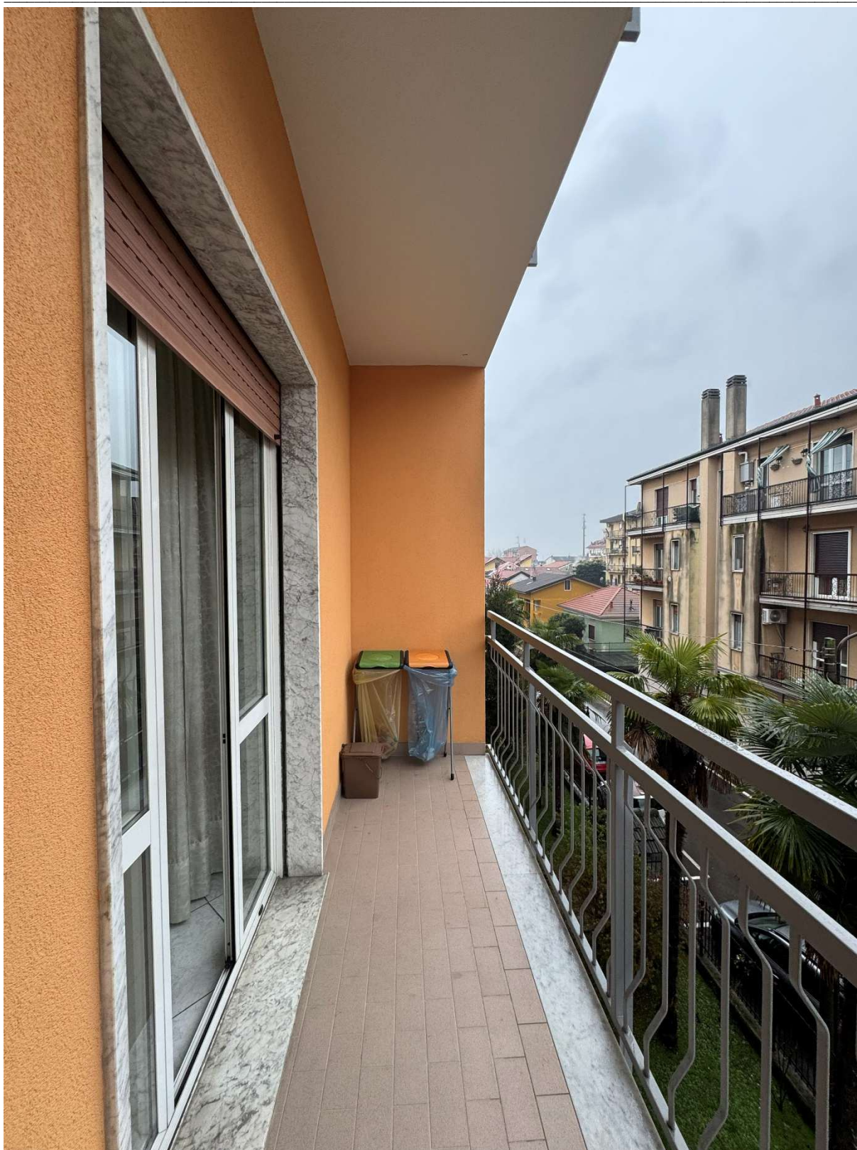
Foto n. 28. Piano Secondo. Balcone 2
