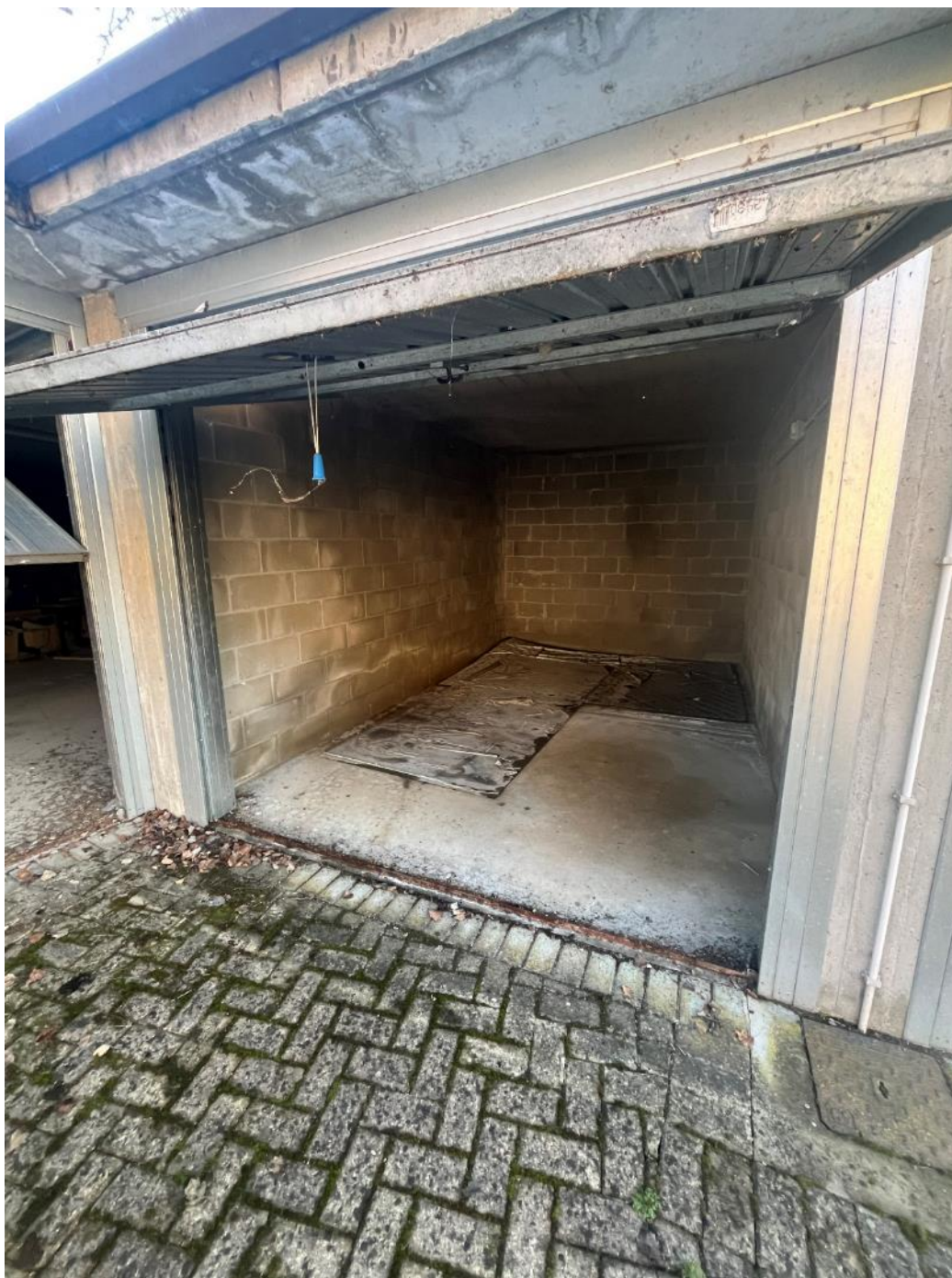
Figura 48: vista dell'interno del bene 6
