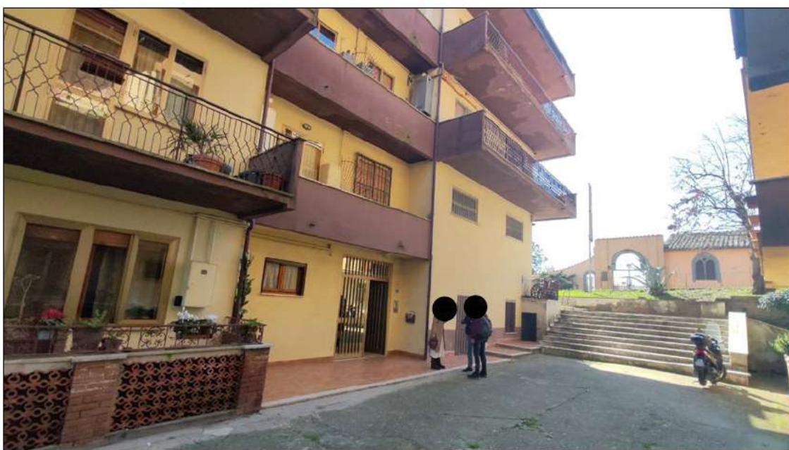
foto 4 - vista dell'ingresso al vano scala dell'edificio.
