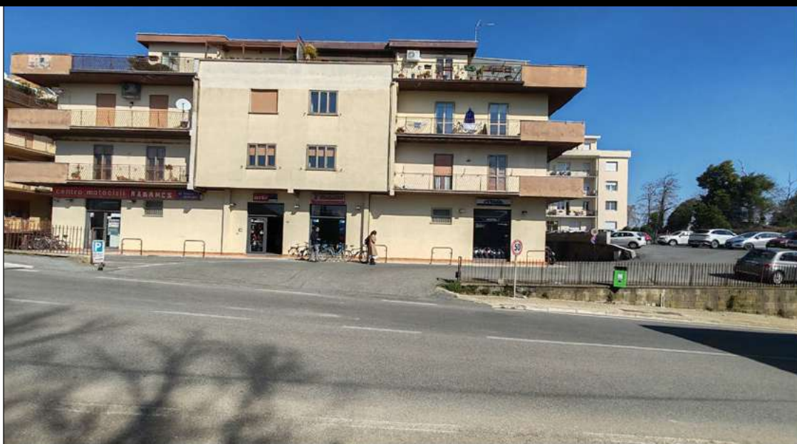
foto 1 - vista esterna dell'edificio dalla strada provinciale.
