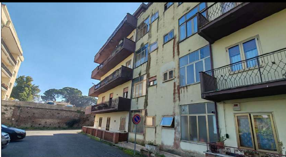
foto 3 - altra vista esterna dell'edificio.
