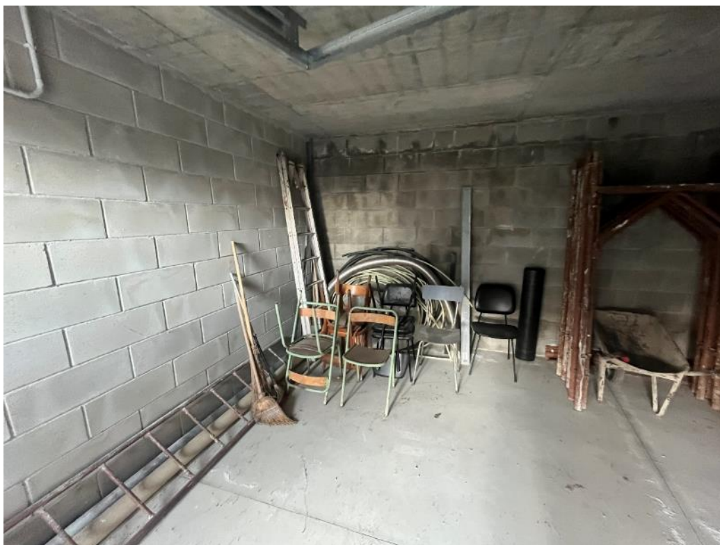
Figura 47: vista dell'interno del bene 5
