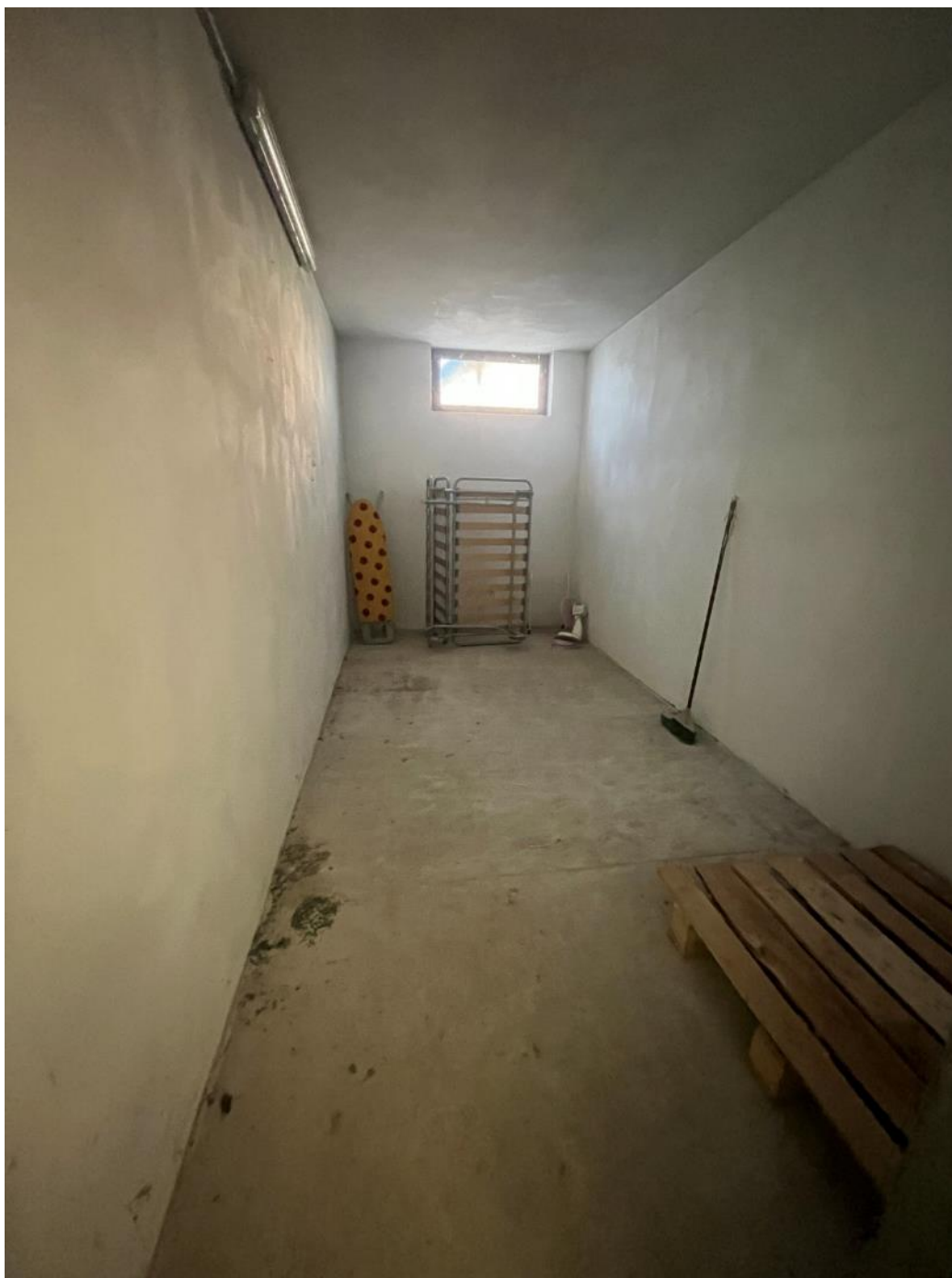
Figura 33: vista della cantina del bene 2
