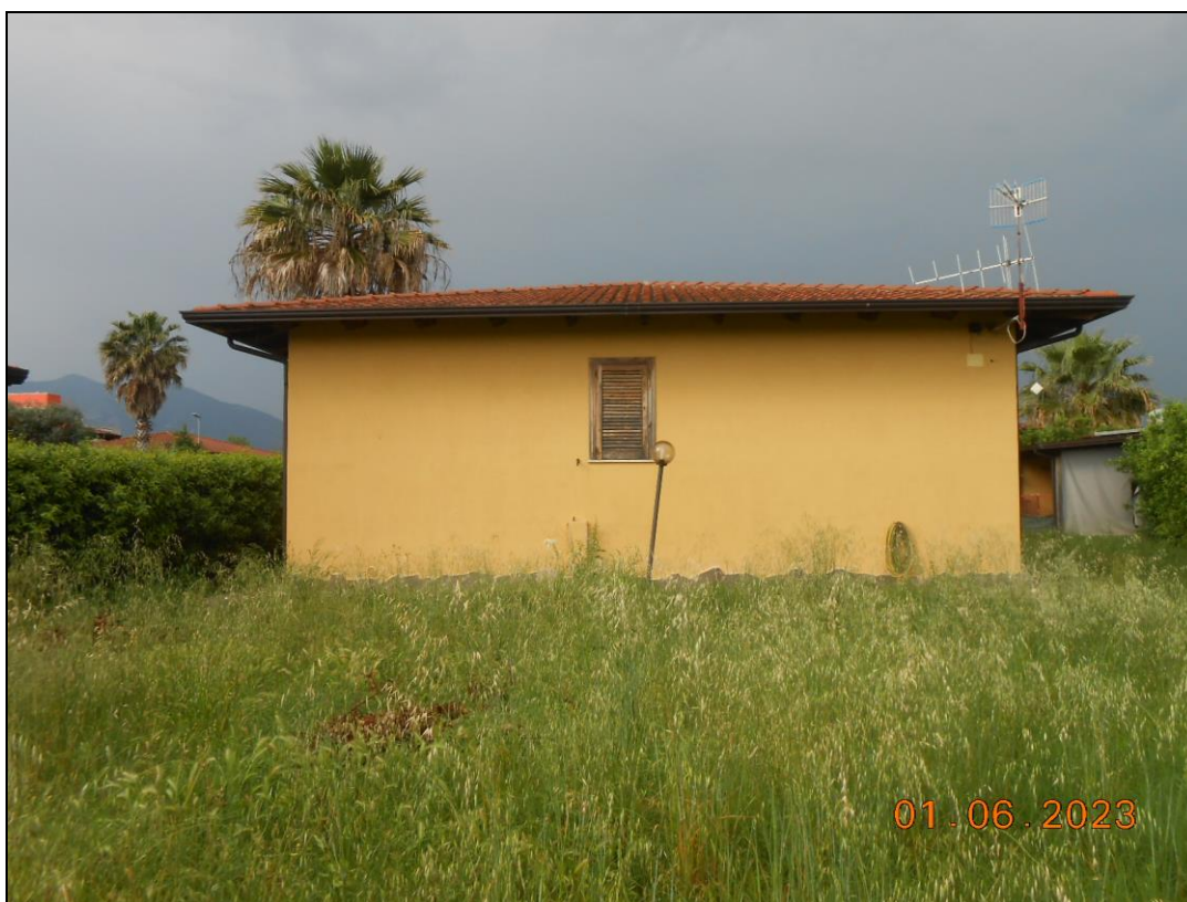
FOTO N. 08 Vista dell'immobile pignorato e la circostante corte a giardino. Si nota lo stato di abbandono.
