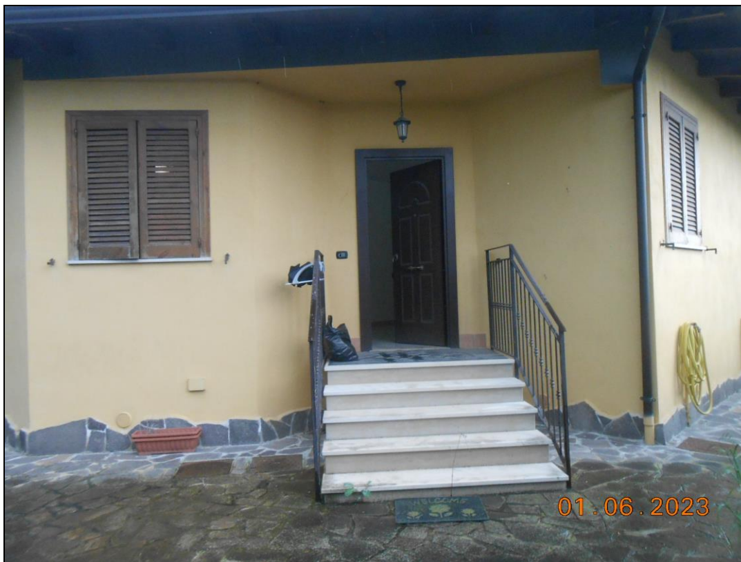
FOTO N. 17 Vista accesso al piano rialzato di circa m 0,90.
