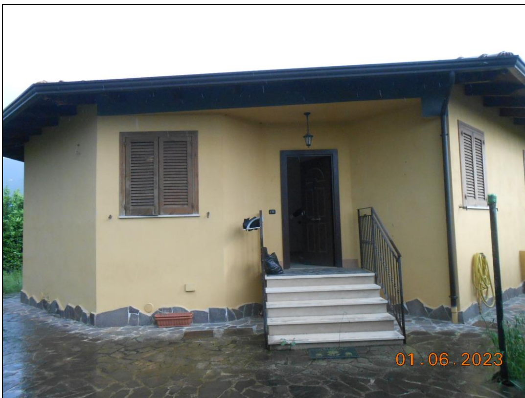
FOTO N. 04 Vista rampa di accesso dell'immobile pignorato.
