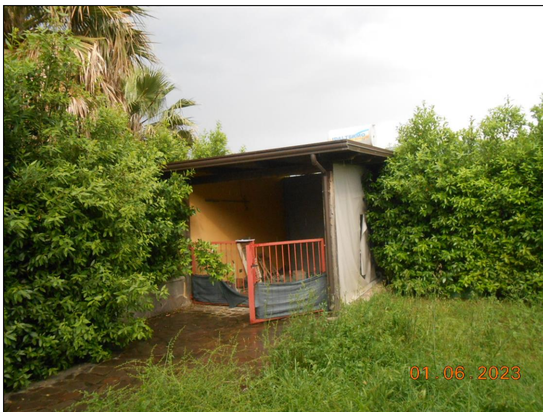
FOTO N. 09 Vista del box – gazebo, collocato nel vertice di confine del lotto.
