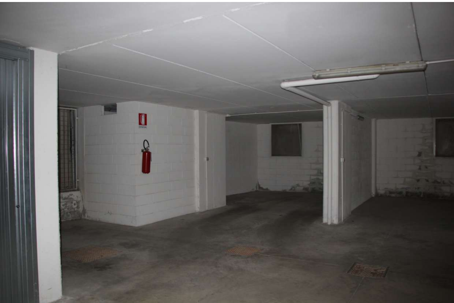
Autorimessa lotto 2G sub 141, piano 2 interrato
