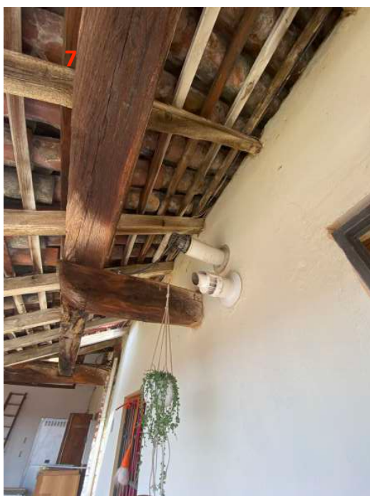
sfogo della caldaietta murale (esterno)
