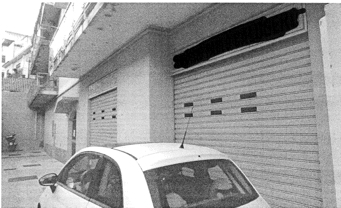
Figura 3 – Ingresso dello stabile
