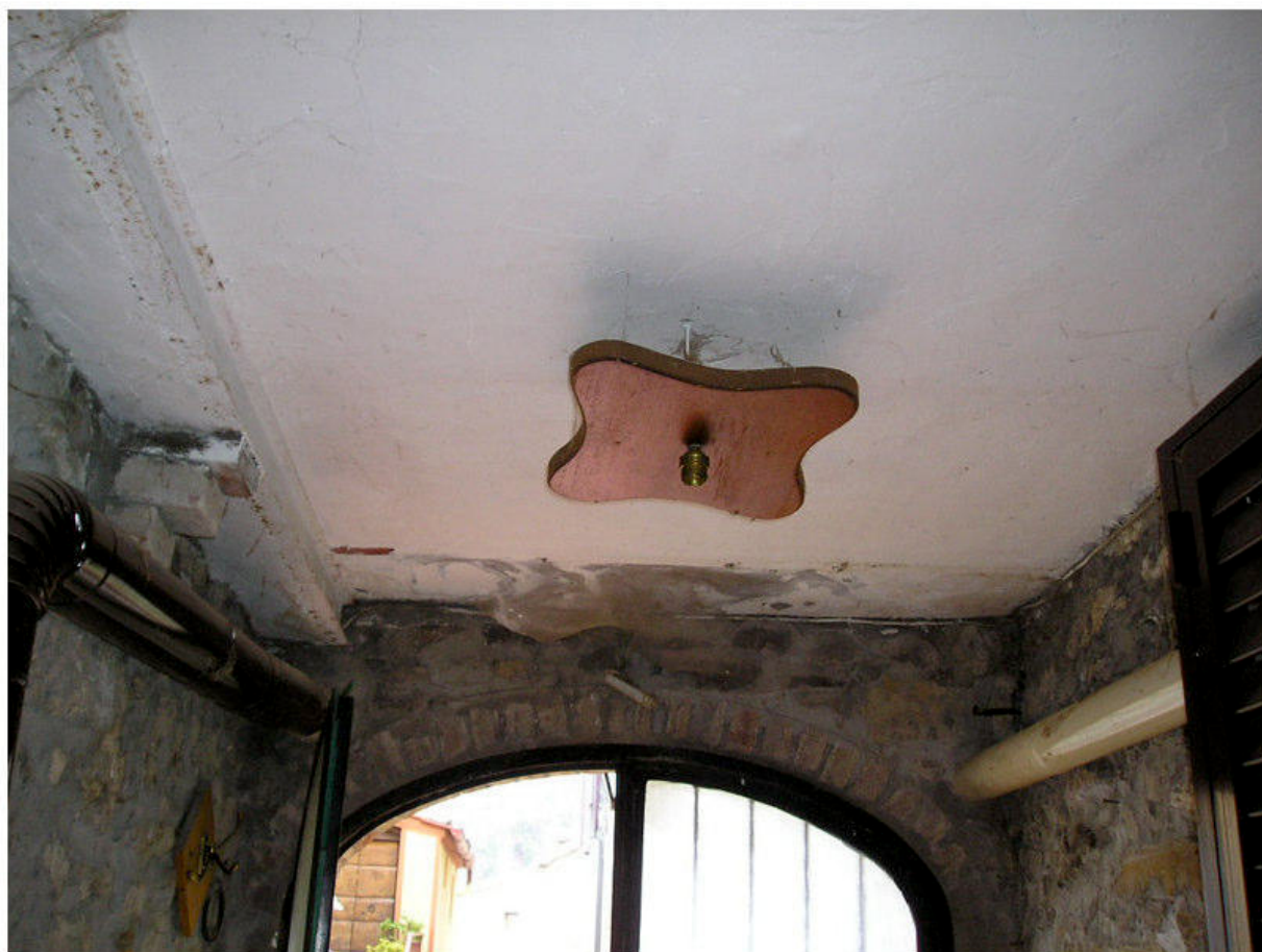
FOTOGRAFIA 31 - Piano Seminterrato / Passaggio Coperto
