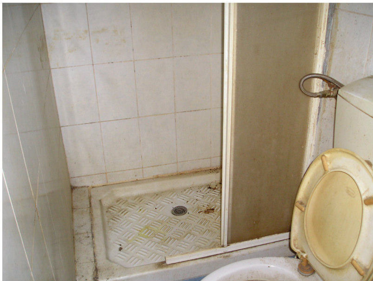
FOTOGRAFIA 27 - Piano Primo / Bagno
