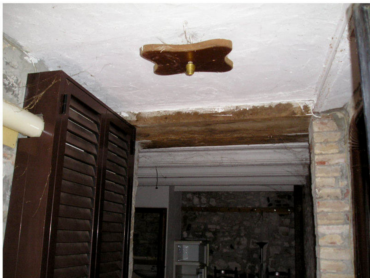
FOTOGRAFIA 32 - Piano Seminterrato / Passaggio Coperto
