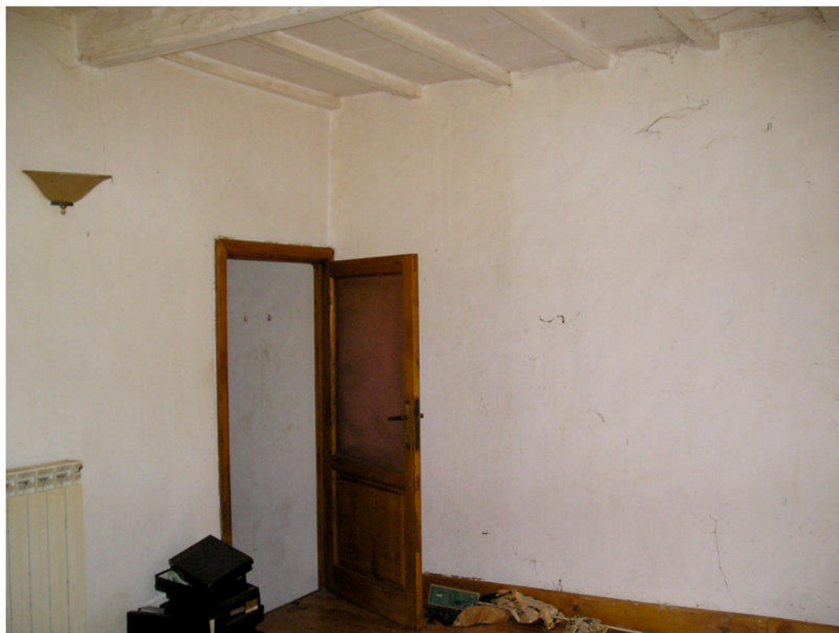
FOTOGRAFIA 25 - Piano Primo / Camera
