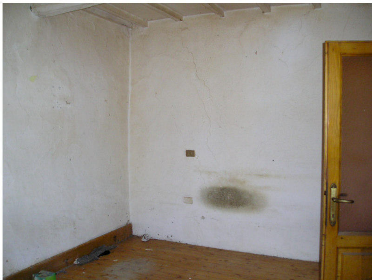
FOTOGRAFIA 26 - Piano Primo / Camera
