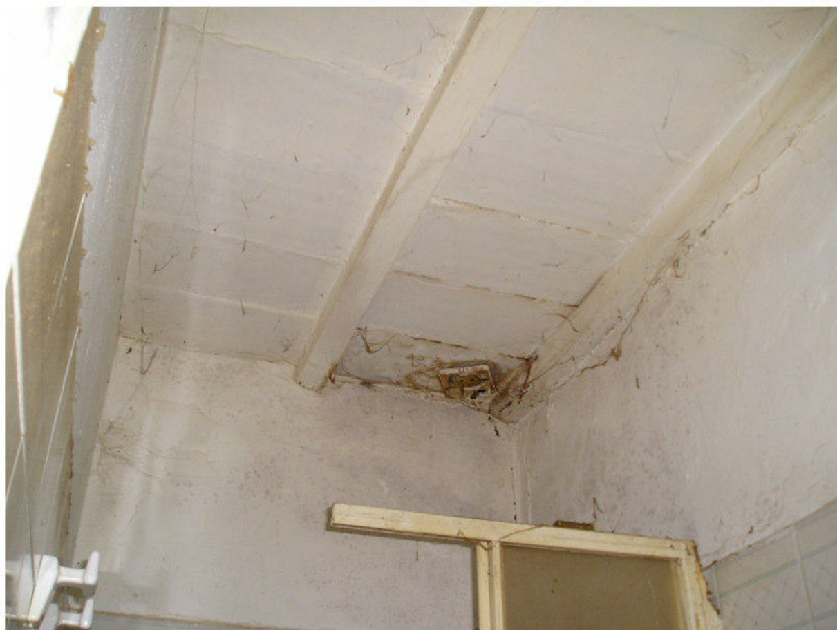
FOTOGRAFIA 28 - Piano Primo / Bagno
