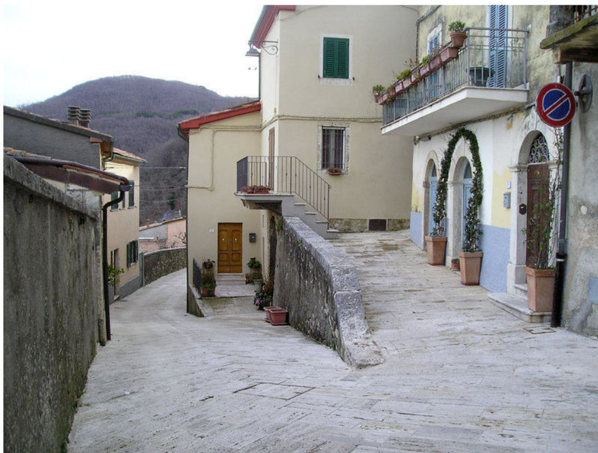
FOTOGRAFIA 09 - Viabilità Pubblica / Sottostante Via Vittorio Emanuele
