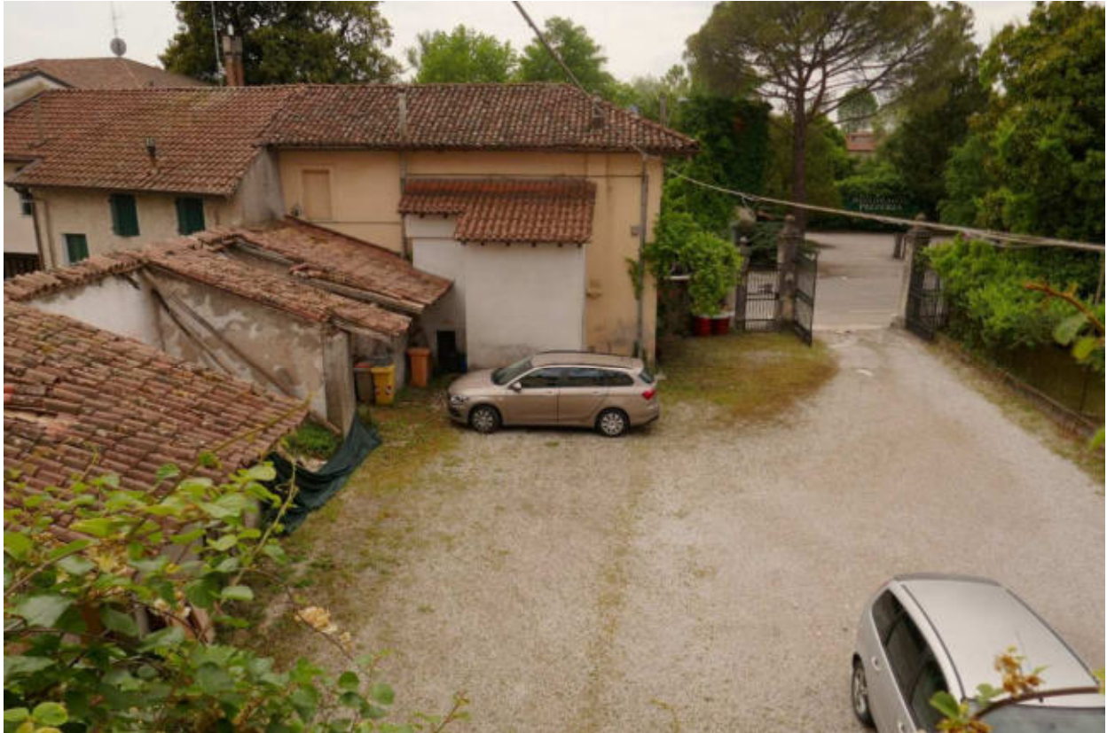
Sulla sinistra, oltre l'automobile color beige, è il retro della abitazione al subalterno 1 in particella 417, mentre all'estrema Sx si notano i depositi collabenti.
