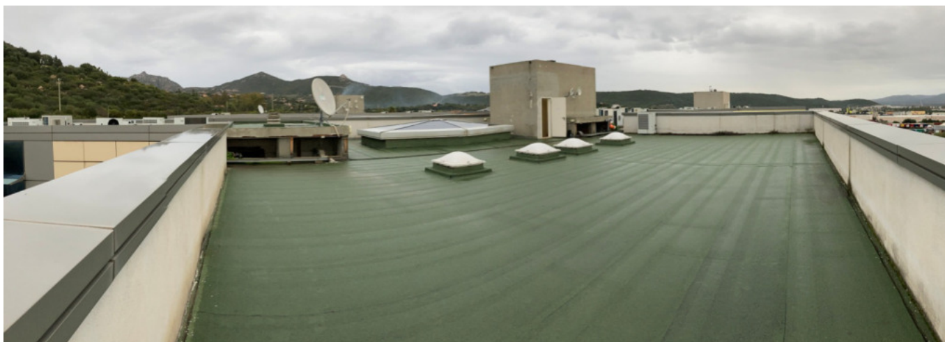
Vista del lastrico solare
