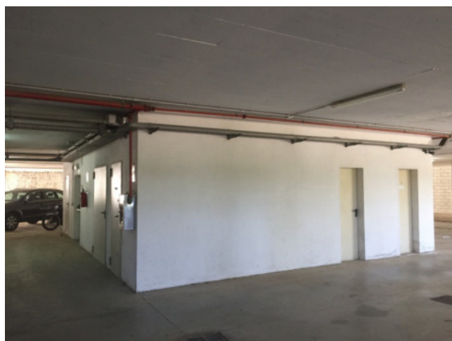
vista dei locali di deposito
