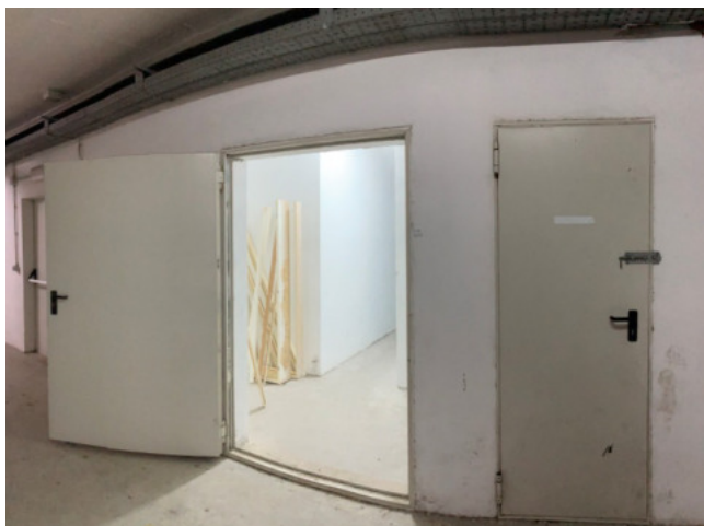
vista verso l'interno del subalterno 357
