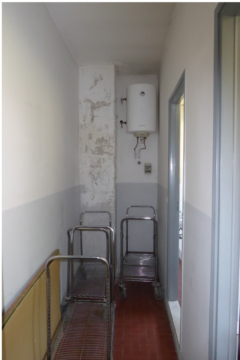
Foto 12: corridoio al piano primo
