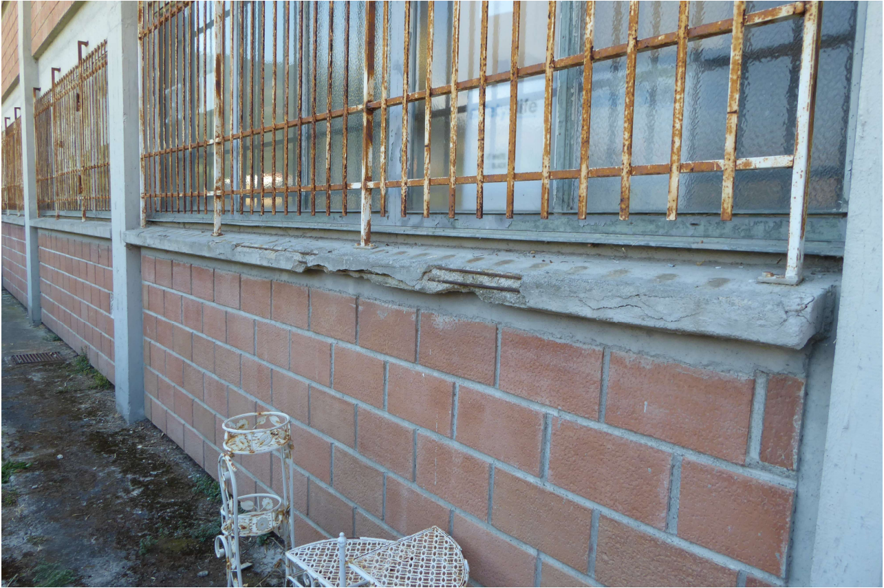
Foto 3: vista laterale del fabbricato sito in Cogorno (Ge), via du Canto 27- 29
