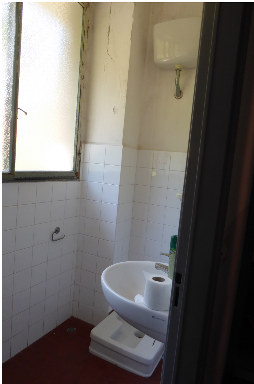
Foto 13: servizio igienico al piano primo
