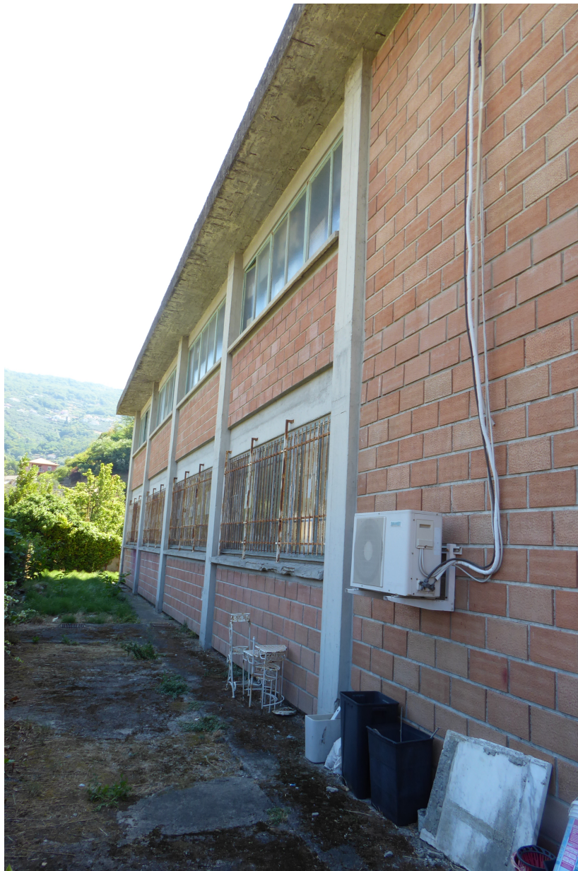
Foto 1: vista laterale del fabbricato sito in Cogorno (Ge), via du Canto 27- 29
