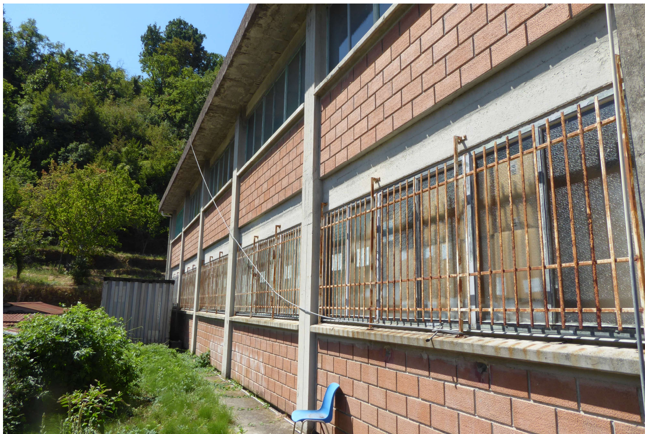
Foto 2: vista laterale del fabbricato sito in Cogorno (Ge), via du Canto 27- 29
