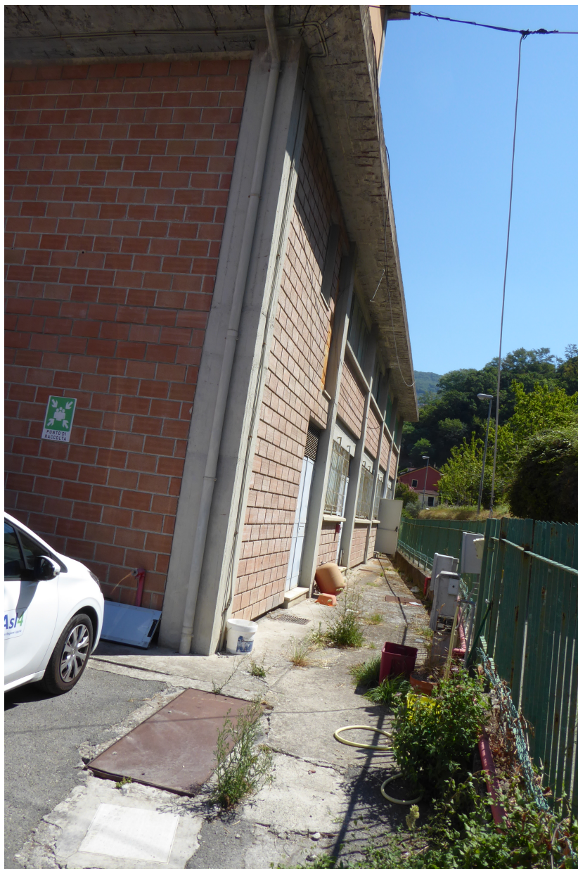
Foto 4: vista laterale del fabbricato sito in Cogorno (Ge), via du Canto 27- 29
