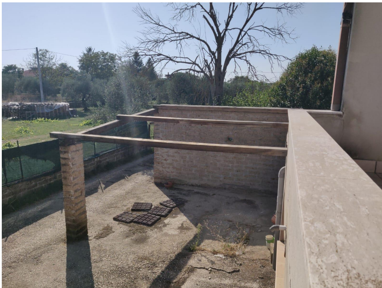
Tettoia smontata in adiacenza al sub. 5
