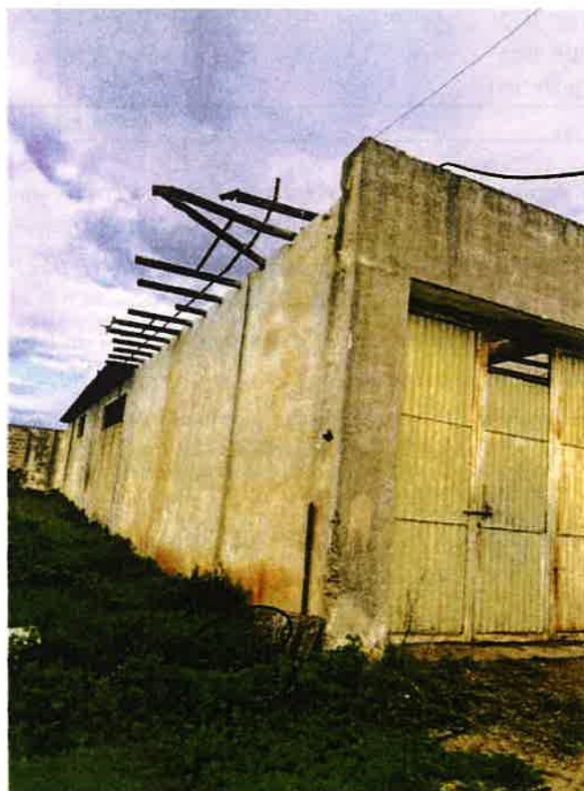
Foto 4 – Esterno deposito attrezzi
