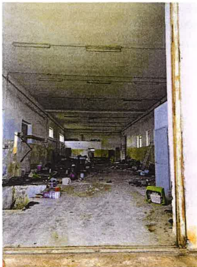
Foto 3 – Interno ex frantoio
